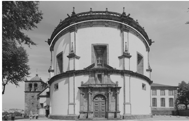
Figura 51 - Capela do Mosteiro da Serra do Pilar. Fonte: adaptado de https://rotaportoliberal.pt/rpl/mosteiro-da-serra-do-pilar/
