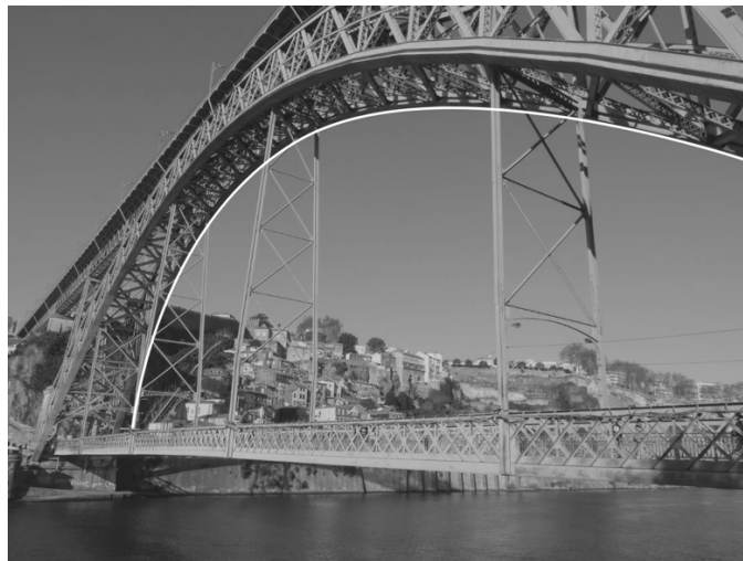
Figura 52 - Ponte D. Luís I. Fonte: adaptado de https://mundoindefinido.com/entre-porto-e-gaia-ou-a-ponte-luiz-i/
