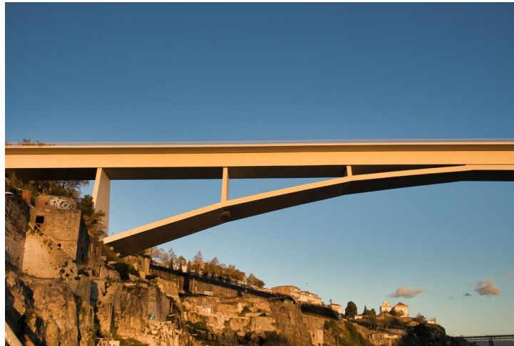
Figura 29 - Ponte Infante D. Henrique, fotografia de Nicolas Janberg. Fonte: https://www.bridgeinfo.net/bridge/index.php?ID=61
