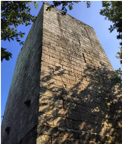
FIGURA 13. TORRE DE VILAR
