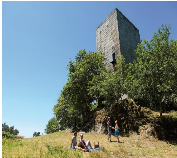
FIGURA 14. TORRE DE VILAR
