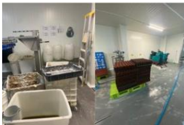
Figura 38 - Sala de lavagem
