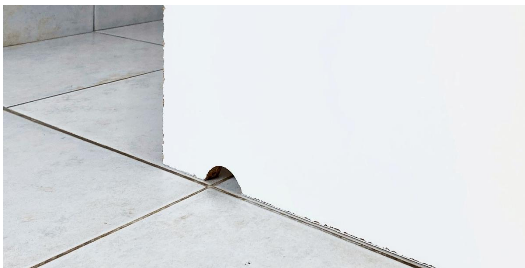
Fig. 33 – Ranhura para passagem dos cabos até à tomada
