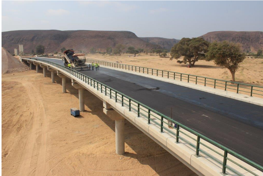
Figura 45 - Ponte sobre o rio Giraul em Angola
