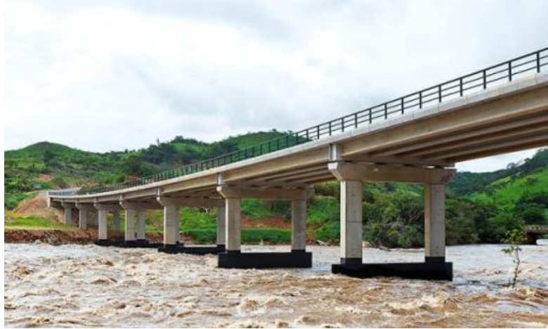
Figura 4 - Ponte pré-fabricada sobre Rio Keve [4]
