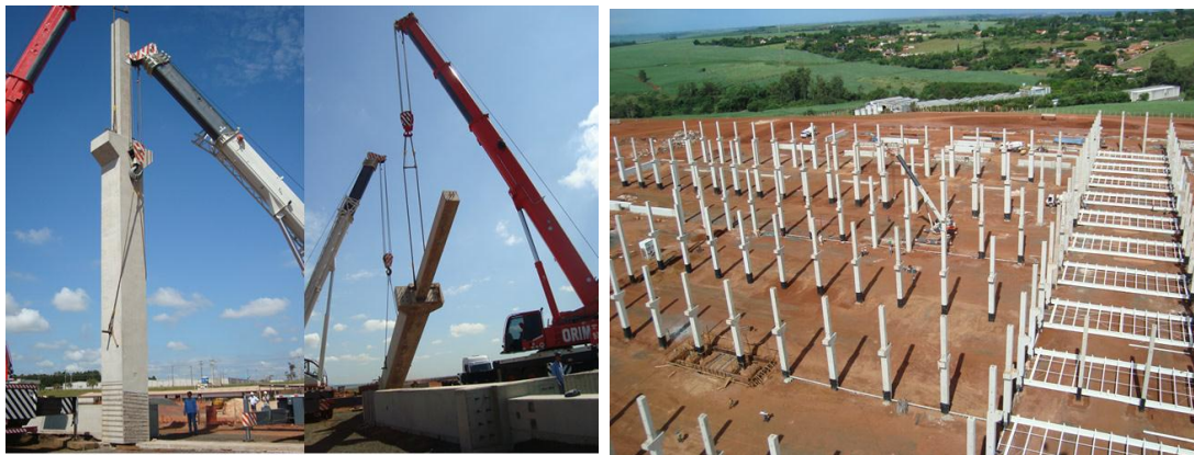
Figura 40 - Montagem de pilares [21]
