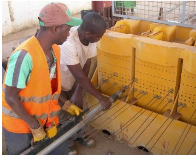
Figura 26 - Ancoragem ativa. Aplicação do pré-esforço nos cordões
