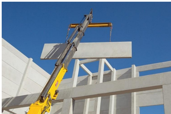
Figura 39 - Montagem de painéis [20]
