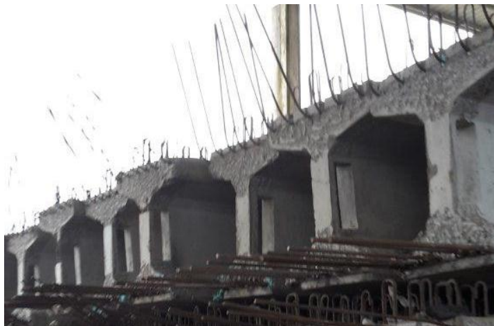
Figura 44 - Vigas I pré-fabricadas
