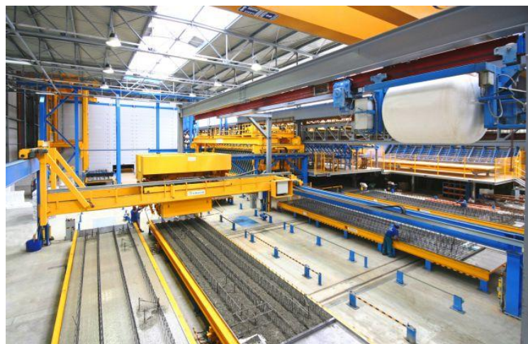
Figura 35 - Transportador aéreo e balde de betonagem [13]
