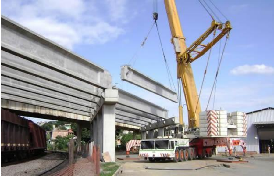
Figura 41 - Montagem de vigas para realização do tabuleiro de um viaduto sobre uma via ferroviária [23]
