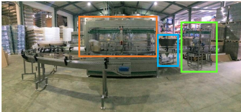
Figura xviii. Vista panorâmica do reservatório, tapete rolante e máquina de enchimento e fecho dos produtos cosméticos. A cor de laranja está representado o local onde as embalagens são enchidas com o cosmético a ser produzido, tendo em conta quantidade deste existente no reservatório exibido a azul, e, por fim, estas são fechadas no local apresentado a verde.
