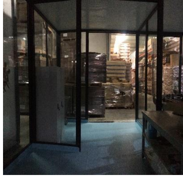
Figura xxii. Vista do interior da zona da antecâmara. Evidência da delimitação da zona da antecâmara e zona limpa, ainda que a porta que as separa não esteja disponível. Dentro da antecâmara encontra-se visível o cacifo.
