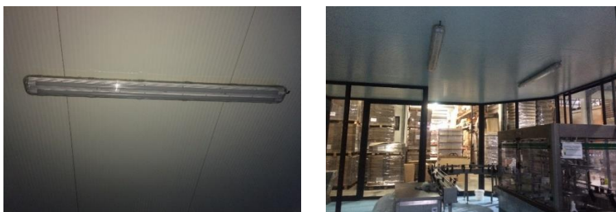
Figura xxvi. Iluminação da sala. A iluminação está presente em locais estratégicos e está devidamente protegida de quebras e quedas. Não se evidenciam interruptores no interior da sala.
