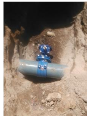
Figura 2.19-Instalação do “tê” [Foto tirada em obra]
