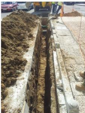
Figura 2.18- Abertura de Vala [Foto tirada em obra]
