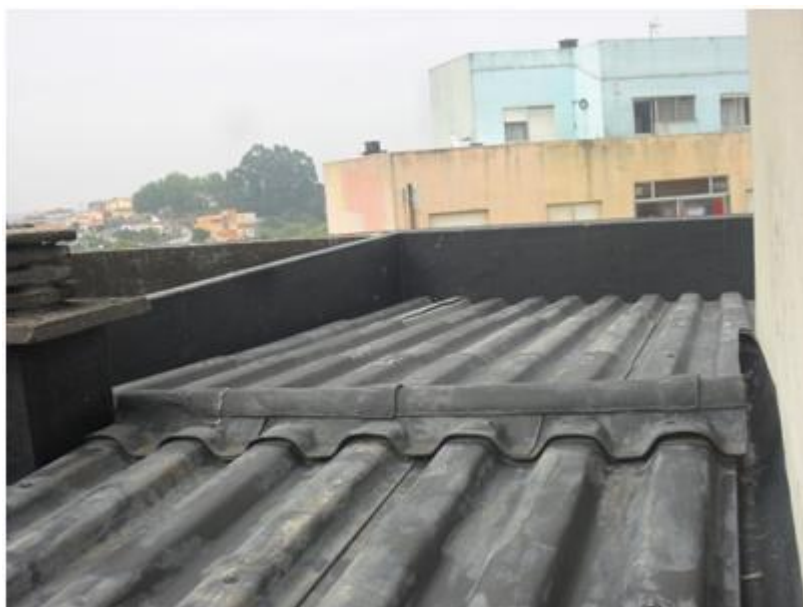
Figura 2.7- Cobertura com chapa de fibrocimento [Foto tirada em Obra]
