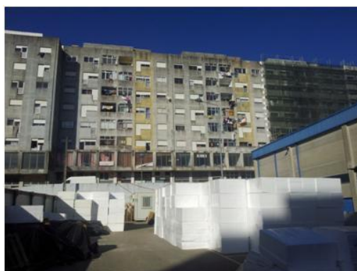
Figura 2.5- Degradação das Fachadas [Foto Tirada em Obra]
