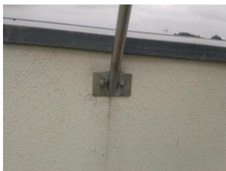
Figura 3.24-Fixação de guardas [Foto tirada em obra]
