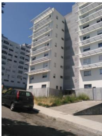
Figura 3.23-Fixação de palas de sombreamento [Foto tirada em obra]
