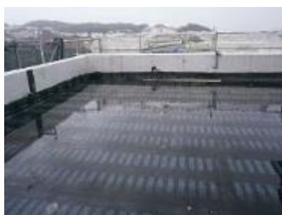
Figura 2.12- Tela Impermeabilizante [Foto tirada em obra]
