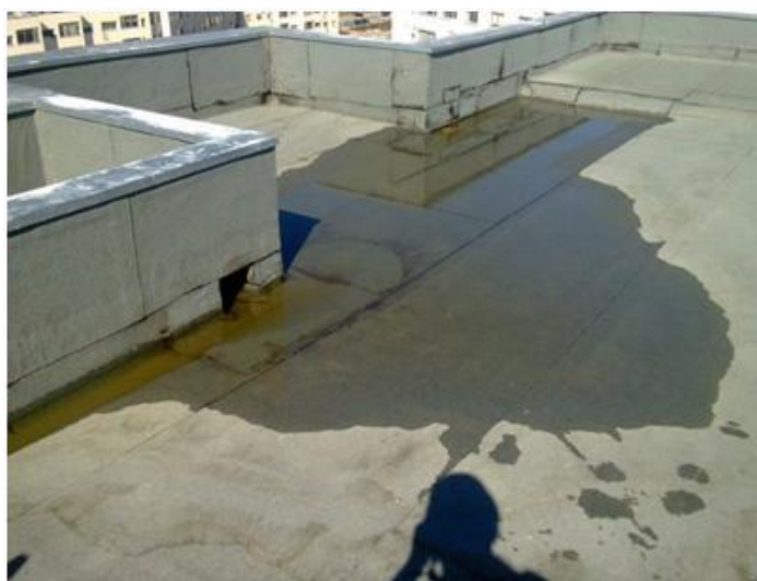
Figura 2.8- Cobertura em Tela Asfáltica [Foto tirada em Obra]
