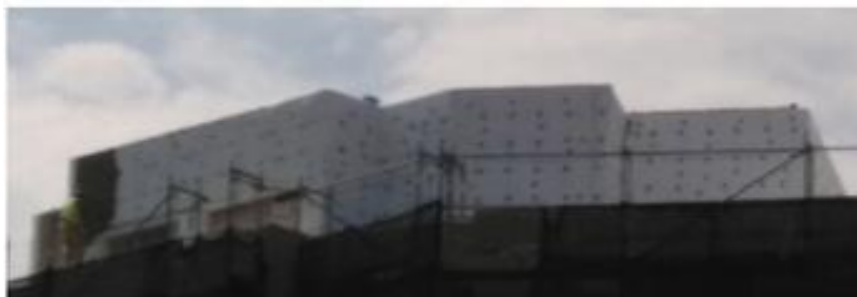
Figura 3.4-Distribuição das buchas para fixação mecânica dos painéis de EPS [Foto tirada em Obra]
