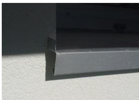
Figura 3.17- Pormenor aba lateral da chapa de alumínio [foto tirada em obra]
