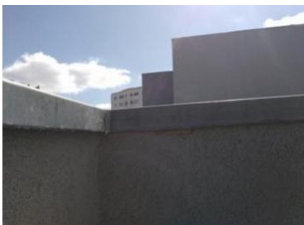
Figura 3.25- Rufagem da platibanda [Foto tirada em obra]
