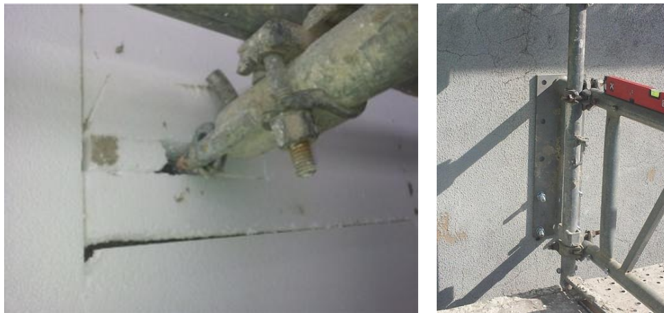
Figura 3.22- Fixação de andaimes [Foto tirada em obra]
