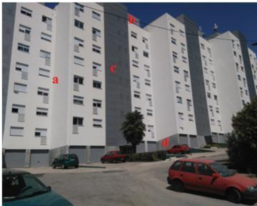
Figura 2.9-Componentes da Intervenção da fachada [Foto tirada em obra]
