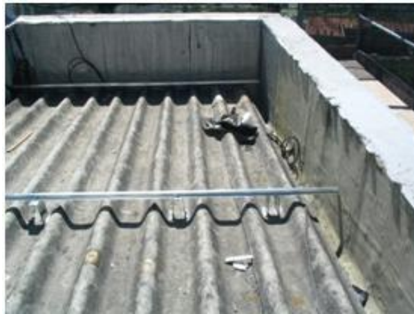
Figura 2.13- Estrutura metálica para montagem de placas sandwich [Foto tirada em obra]
