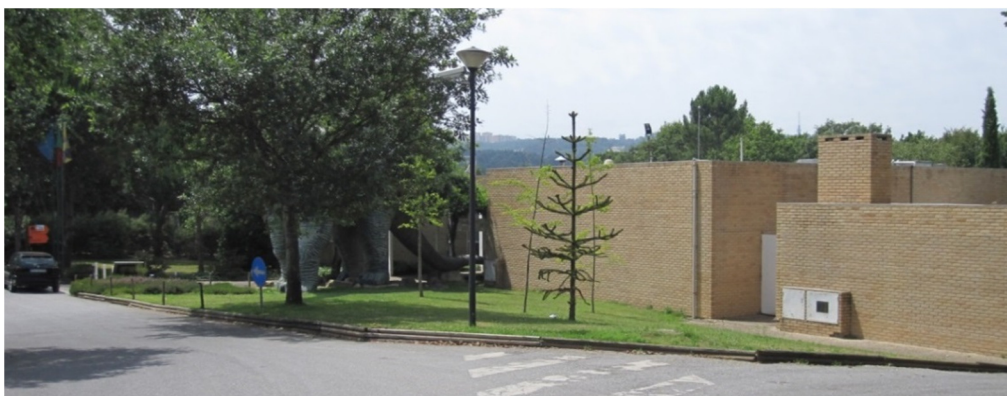
Figura 2.1 – Fachada da entrada principal do edifício.
