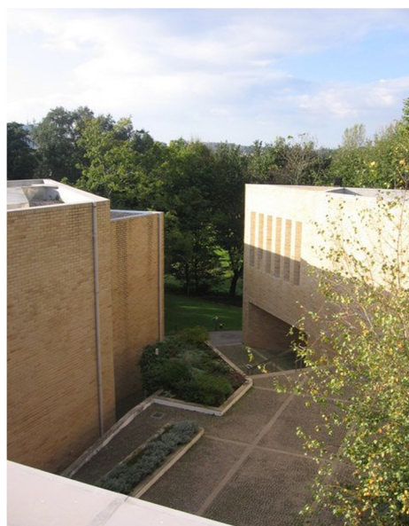
Figura 2.2 – Fachada posterior do edifício principal do PBG, vista de frente (à esquerda) e uma vista parcial desta mesma fachada vista de trás, evidenciando a orientação da mesma (à direita).
