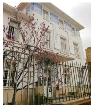
Figura 6. Atual fachada do CMP
