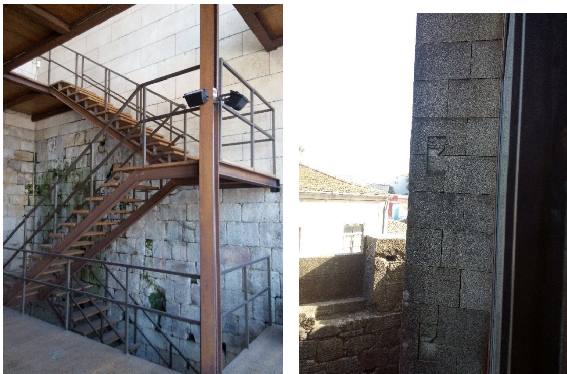
Figura 14: fotografias de visita ao edifício mostram a convivência entre os tempos diferentes do edifício e a marcação do palmo nas pedras
