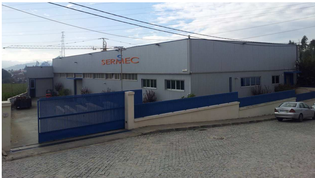
Figura 22 – Instalações da Sermec II
