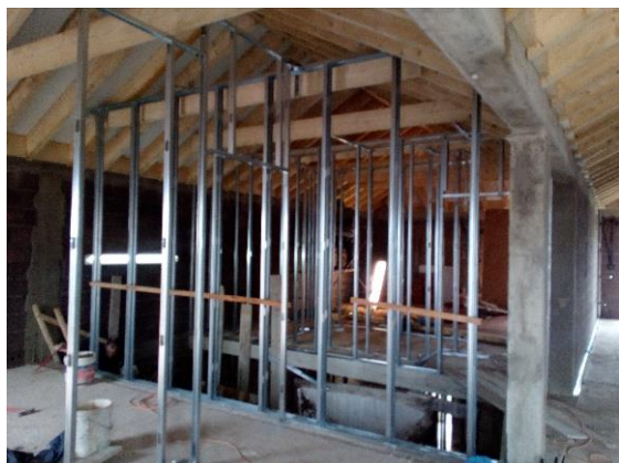
a) Execução da estrutura com perfis metálicos.
