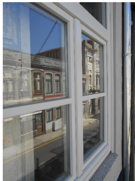
b) Aspeto da caixilharia colocada
