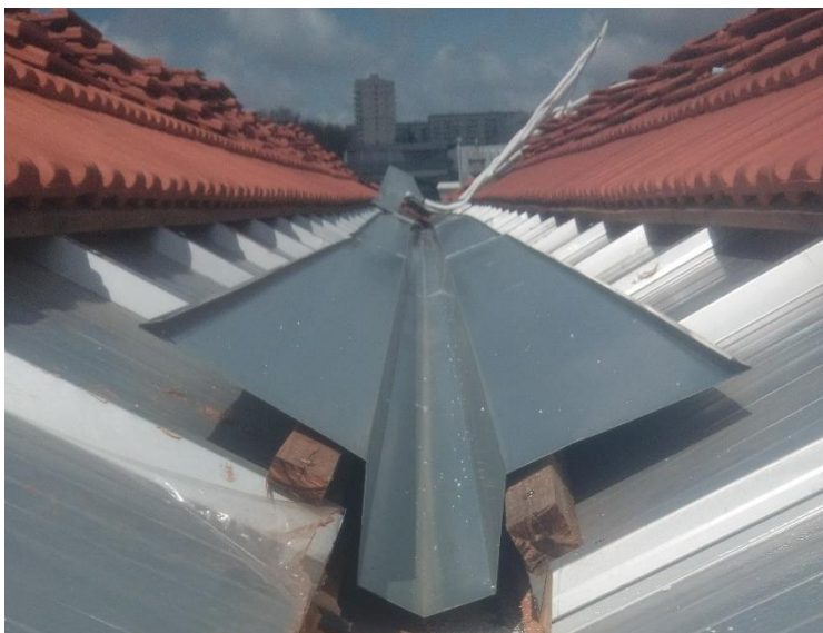
Figura 4.25-Caleira em zinco, na interseção das duas águas do telhado.
