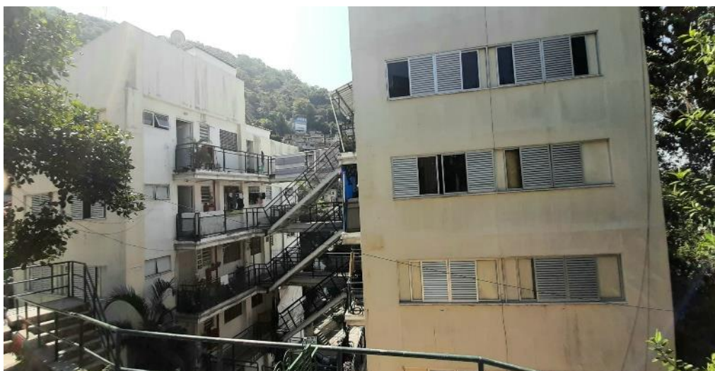
Figura 16 - Fachada traseira do Hab 2 (Autora)
