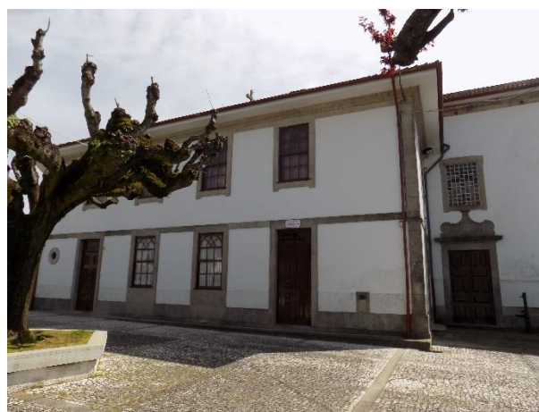
d) Fachada Lateral Norte (Zona Anexo – a nascente)
