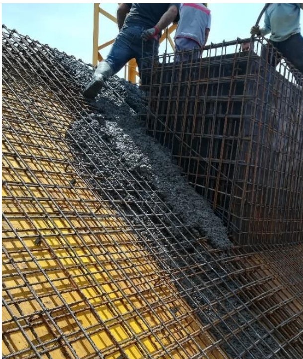
a) Betonagem da cobertura inclinada
