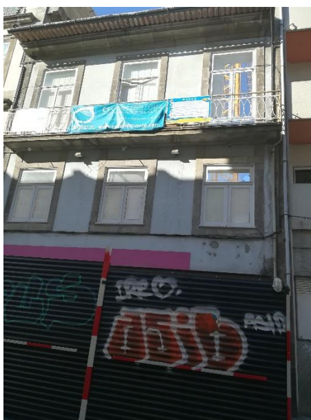
Figura 2.4.4 - Fachada principal antes do início dos trabalhos
