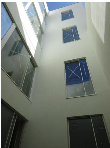
c) Preparação e pintura da fachada tardoz
