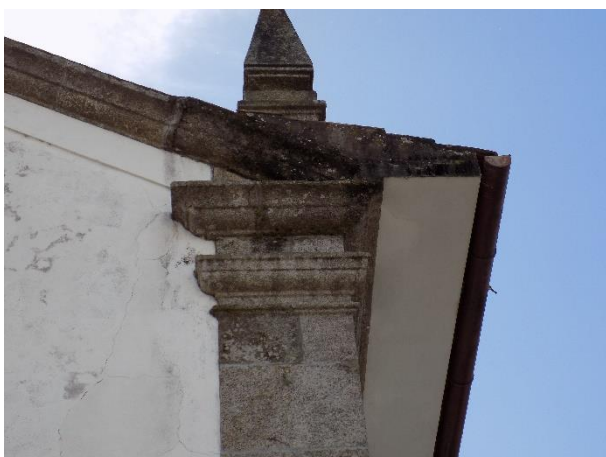
a) Foto de pormenor do beiral antes da intervenção
