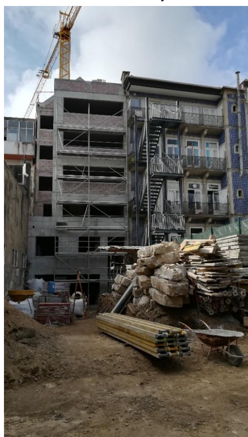
g) Fachada tardoz do edifício principal
