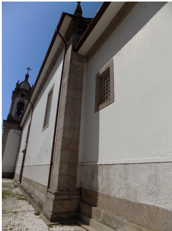
Figura 3.2.6 - Fachada orientada a sul
