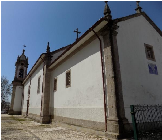
e) Fachada Lateral Sul
