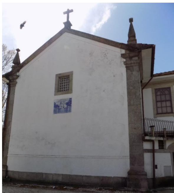
Figura 3.2.5 - Fachada tardoz da Igreja Matriz
