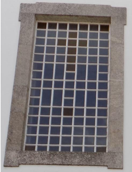
a) Vão Envidraçados do corpo da Igreja
