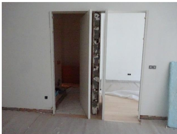
b) Colocação de portas pivotantes
