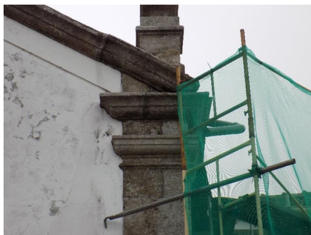
b) Foto de pormenor do beiral após intervenção
