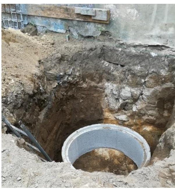
d) Execução de poço de bombagem para águas residuais
