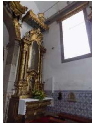
Figura 14 - Manchas de humidade devido a infiltrações na cobertura e ascensão da água por capilaridade na parede orientada a sul
