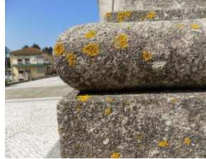
Figura 12 - Acumulação de musgos e vegetação parasitária ou colonização biológica na base da torre sineira em granito a sul
