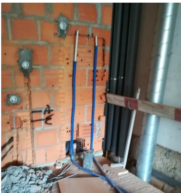
c) Abertura de roços para passagem de infraestruturas elétricas
