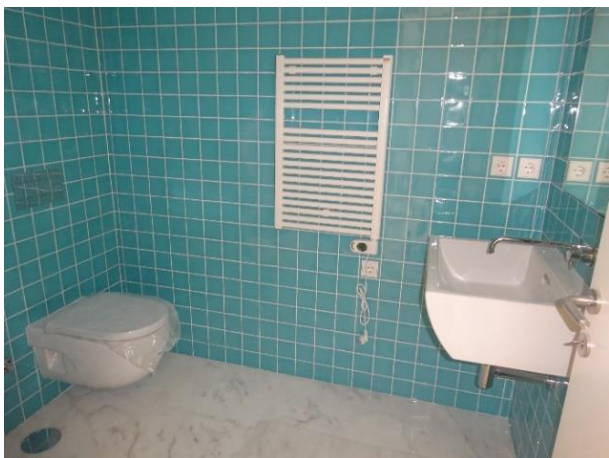
e) Instalação de equipamentos de instalações sanitárias
