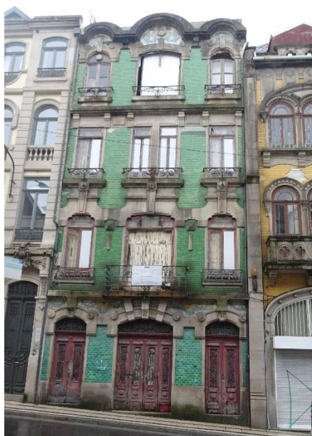
Figura 2.4.2 - Fachada de Alexandre Braga antes do início dos trabalhos
