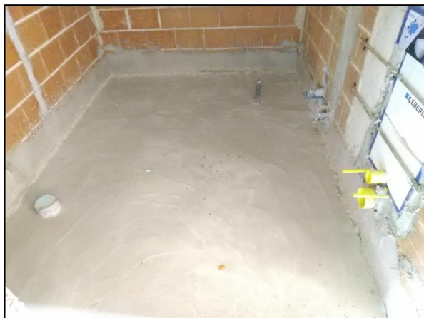
a) Pormenor de ceresite no chão de uma casa de banho.
