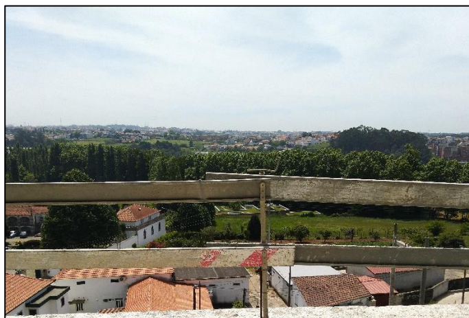
Figura 3.17 – Pormenor de utilização de EPC's no caso de estudo nº1 (autor).
