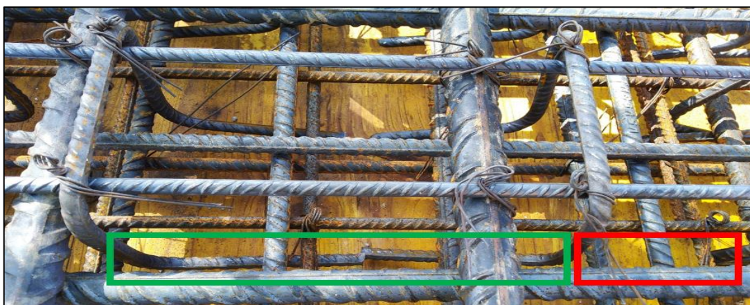
Figura 3.72 – Estribos em direções opostas (autor).
