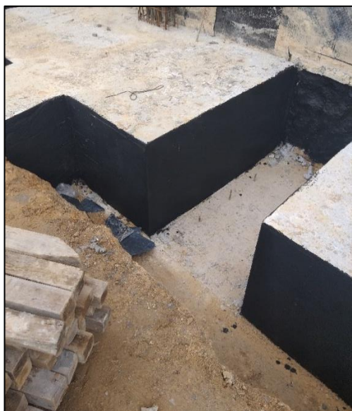
a) Pormenor de aplicação de emulsão betuminosa nas laterais das sapatas
