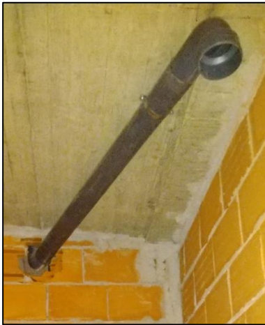
a) Pormenor de tubagem de extração de ar. b) Pormenor de tubagens de captação de ar.
