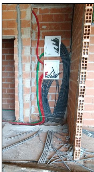
a) Colocação das tubagens elétricas e união no ATI.
