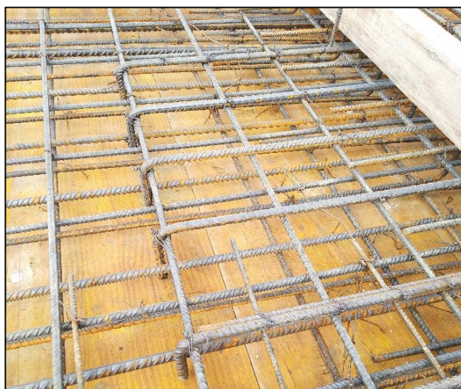
Figura 3.68 – Pormenor de amarração de armaduras inferiores longitudinais da laje do piso -1 (autor).
