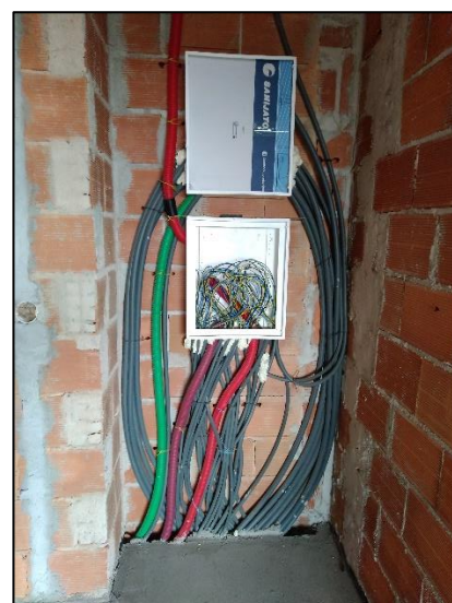
c) ATI com cabos após aplicação de betonilha.
