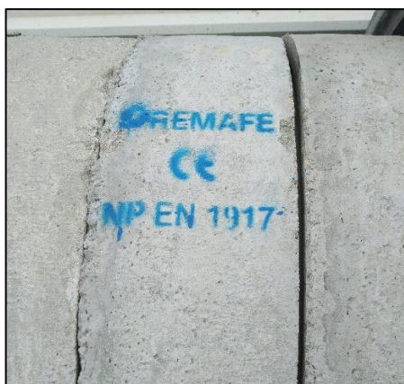
c) Pormenor de norma e marcação CE em peças da rede de drenagem de ARD
