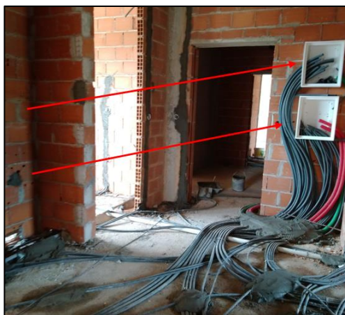
b) Pormenor da instalação do ATI após a sua correção
