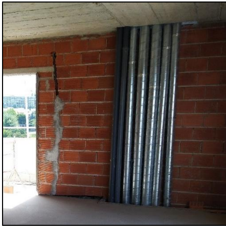
a) Pormenor de courette antes do fecho da parede.
