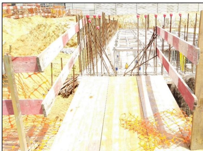
Figura 3.16 – Pormenor de utilização de EPC's no caso de estudo nº1 (autor).
