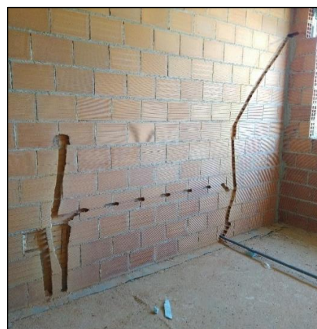
b) Abertura dos roços nas zonas marcadas
