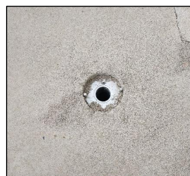
c) Dreno embebido na camada de betonilha.
