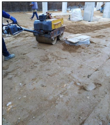
b) Pormenor de utilização de rolo compressor.
