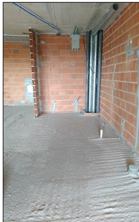
b) Pormenor do pavimento após a aplicação do betão leve
