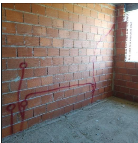
a) Marcação de equipamentos
