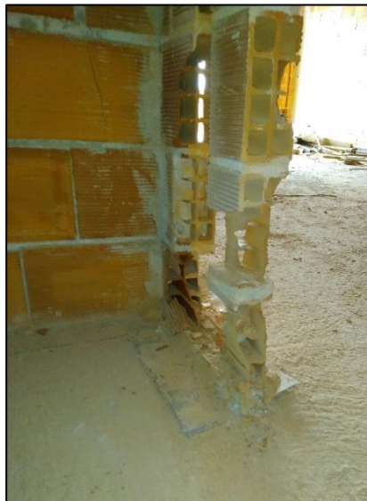
b) Abertura de roços para tubagens de aspiração central
