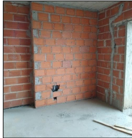
b) Pormenor de courette após o fecho da parede.
