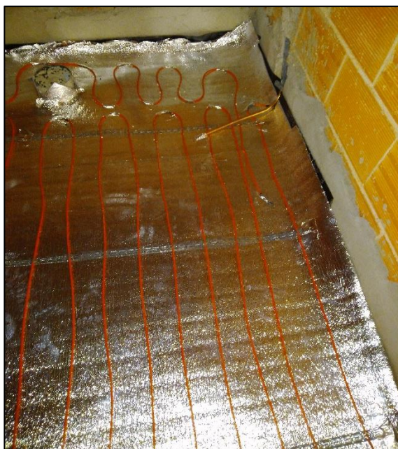
Figura 3.57 – Instalação de pavimento radiante (autor).
