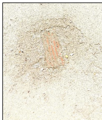
b) Enchimento de betonilha até à marca do tento
