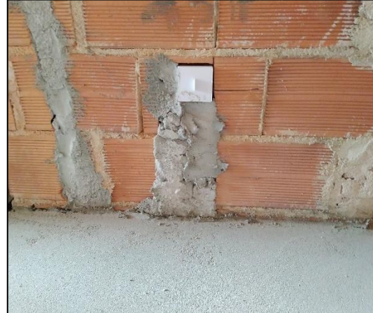
b) Pormenor de tomada de aspiração, após execução de betonilhas.
