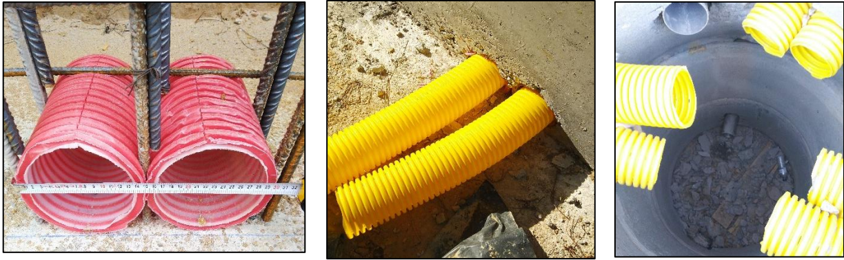
a) Pormenor dos tubos “passadores” b) Pormenor do escoamento pelos geodrenos c) Pormenor de recolha de águas pluviais
