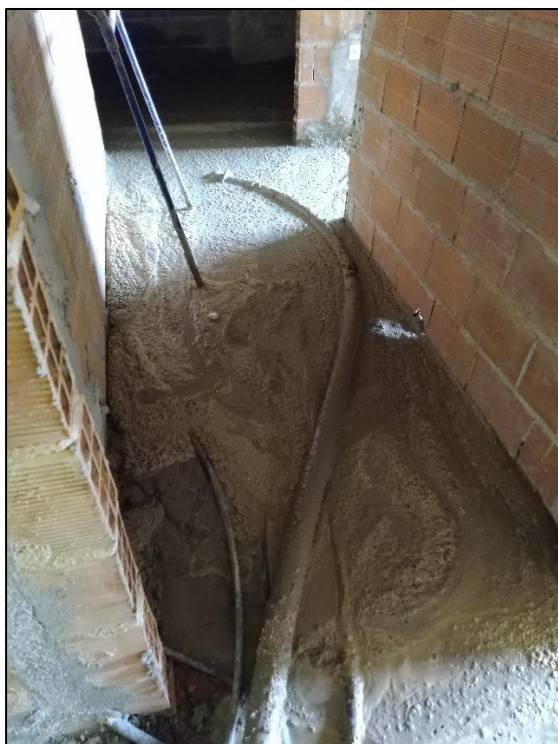
a) Pormenor de aplicação do betão leve
