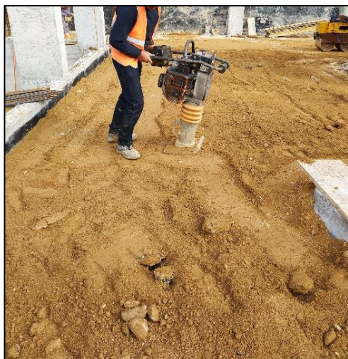
a) Pormenor da utilização de compactador ligeiro.
