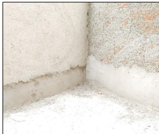
b) Pormenor de “chapisco”, ceresite e reboco numa varanda.
