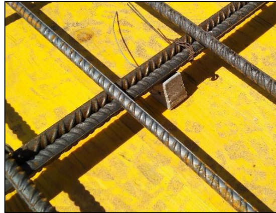
d) Recobrimento inferior em lajes
