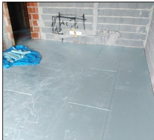
b) Pormenor de colocação de isolamento XPS no pavimento
