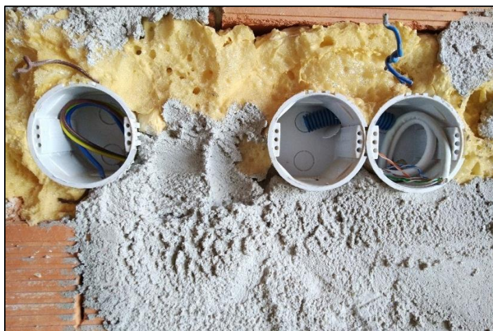
b) Pormenor de cabos elétricos já passados pelas tubagens elétricas.
