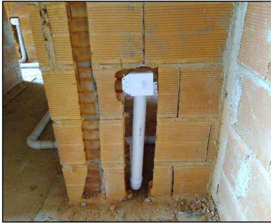
a) Pormenor de tomada de aspiração, antes da execução de trabalhos no pavimento.
