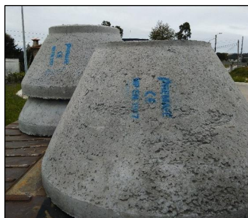
d) Outro pormenor de norma e marcação CE em peças da rede de drenagem de ARD
