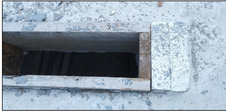
Figura 3.76 – Acerto de dimensões de negativo com esferovite (autor).
