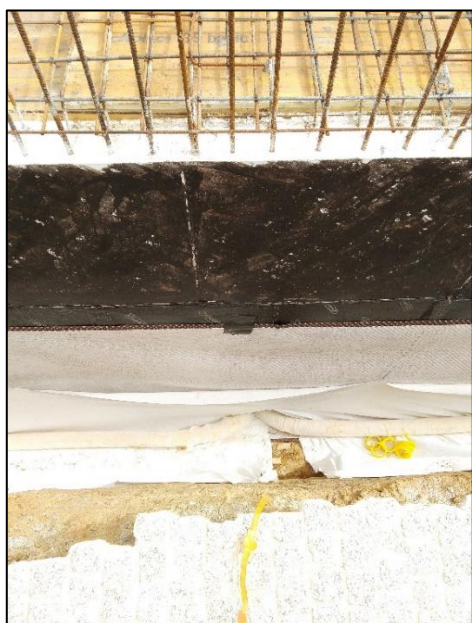
a) Pormenor de geotêxtil e geodrenos 1
