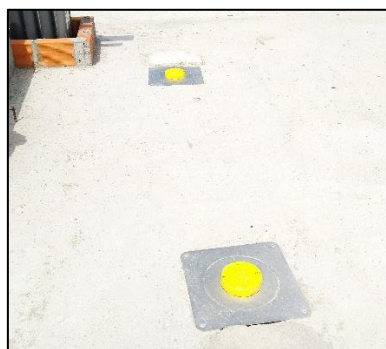
a) Instalação do dreno na cobertura.
