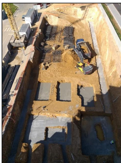
Figura 3.15 – Edifício Altavista17 (autor).
