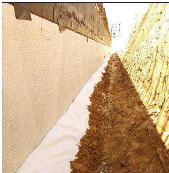
Figura 3.39 – Geodrenos já colocados e tapados por manta permeável (autor).
