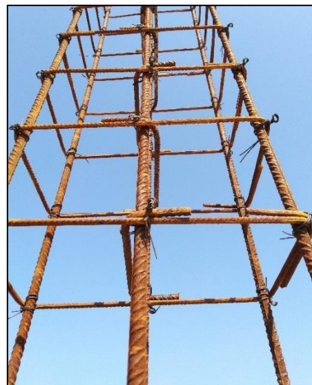
b) Estribos alternados em pilar do piso térreo (autor)
