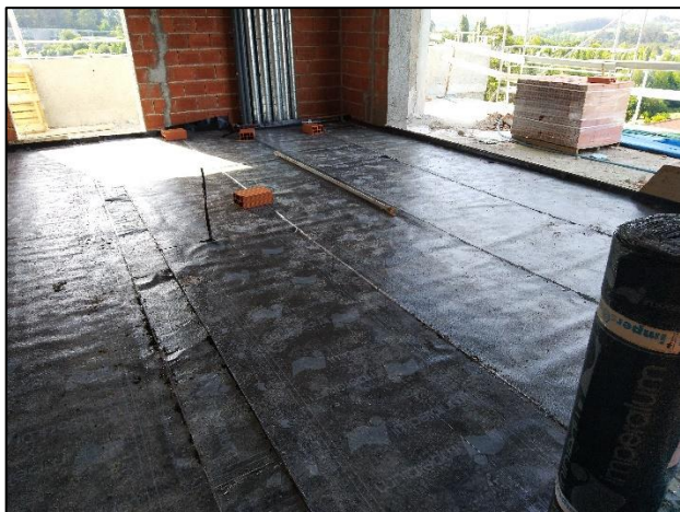
a) Pormenor de colocação de manta acústica no pavimento
