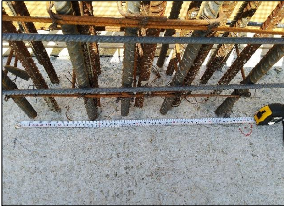
c) Recobrimentos em pilares
