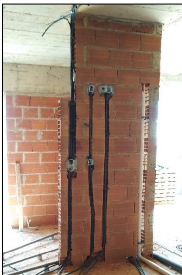
a) Abertura de roços para tubagens de eletricidade e de aspiração central
