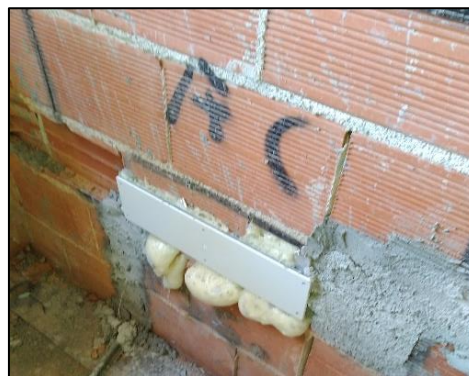
b) Instalação da caixa de AC
