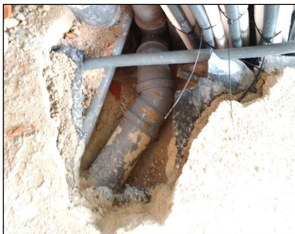
Figura 3.60 – Tubagem de ARD substituída (autor).
