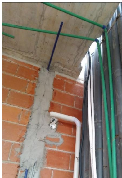
b) Pormenor de passagem de tubagens de unidade de AC para a cobertura.
