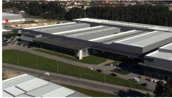
Figura 35 – Instalações da Motofil
