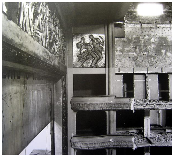
Figura 102 – Obras no Teatro Rivoli que levaram a remoção dos camarotes do auditório, 199? (Fonte: Base Iconográfica de Teatro em Portugal)
