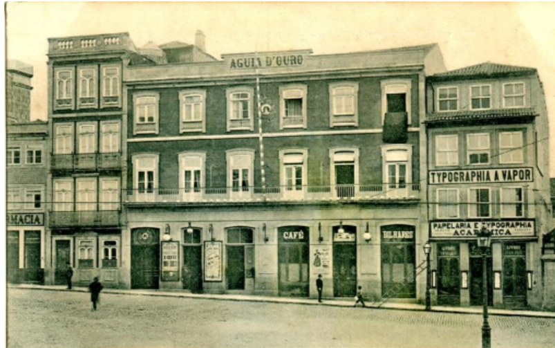
Figura 85 – Fachada do Teatro Águia D'Ouro, 1905 (Fonte: Arquivo Municipal do Porto)
