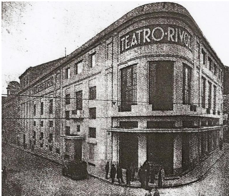
Figura 99 – Fachada do Teatro Rivoli antes das remodelações de 1940, 1933? (Fonte: Base Iconográfica de Teatro em Portugal)
