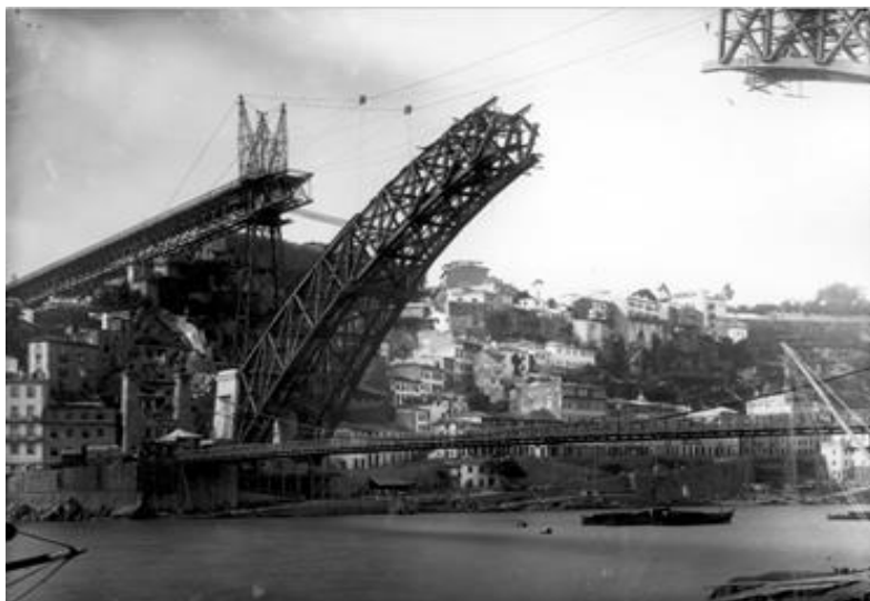
Figura 57 – Construção da Ponte Luís I, avistando-se ainda a “Ponte Pênsil”, 1883 (Fonte: Arquivo Municipal do Porto)
