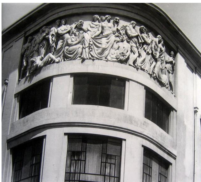
Figura 100 – Pormenor da fachada do Teatro Rivoli após as remodelações de 1940, 194? (Fonte: Base Iconográfica de Teatro em Portugal)
