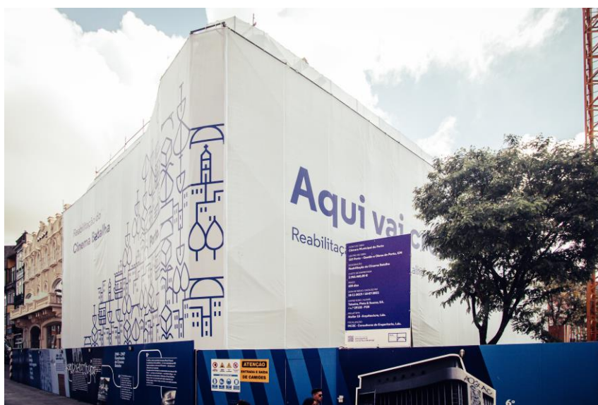
Figura 74 – Obras de requalificação do Cinema Batalha, 2020 (Fotografia de R.J. Gomes)
