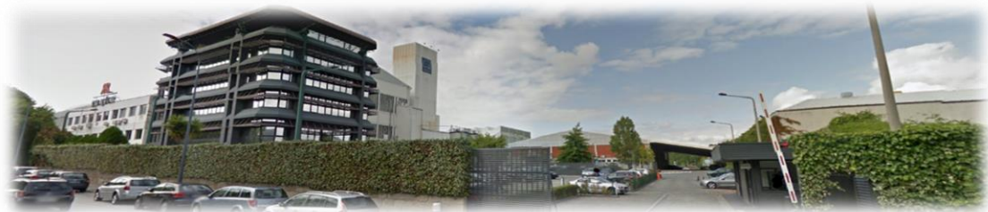
Figura 2.12. Instalações da fábrica da RAR Açúcar, no Porto
