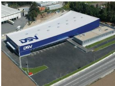
Figura 3 – Instalações da DSV Transitários em Vilar do Pinheiro
