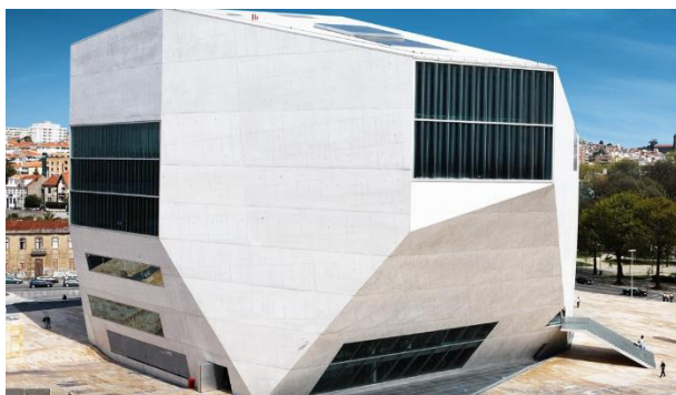
a) Edifício da Casa da Música, em betão branco (Fonte: secilpro.com)
