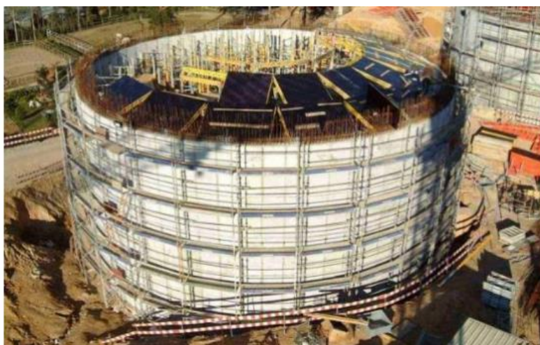
Figura 2.8 – Utilização de betão autocompactável (Fonte: engenharia.mota-engil.pt)
