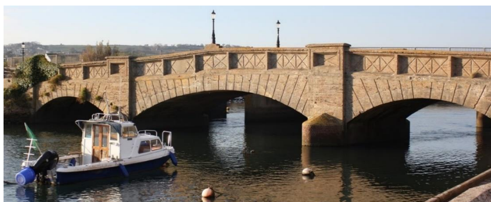
Figura 2.3 – Axmouth Bridge, construída em 1877 (Fonte: viewfromsomerset.pt)
