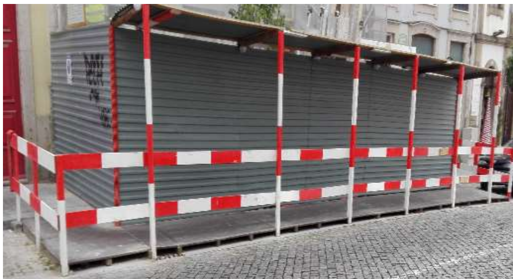
Figura 3.12 – Vedação do estaleiro e passadiço
