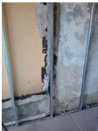
a) Aplicação de estrutura para gesso cartonado
