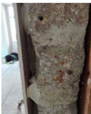
Figura 4.13 – Aplicação de forra em parede existente
