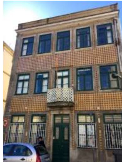
b) Fachada de um edifício situado na rua Firmeza nº 107
