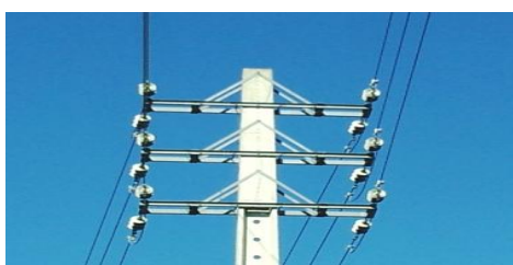
Figura 12. Armação em esteira vertical dupla para ângulo (EVDAN) [12]
