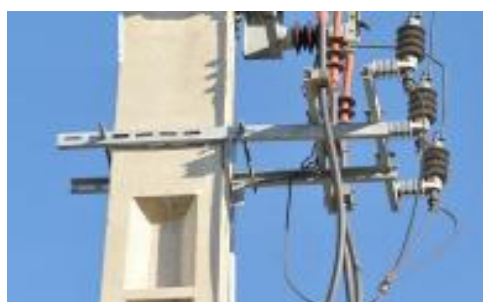
Figura 17. Ferragem suporte de DST/CX (para transição rede aérea-subterrânea) [12]
