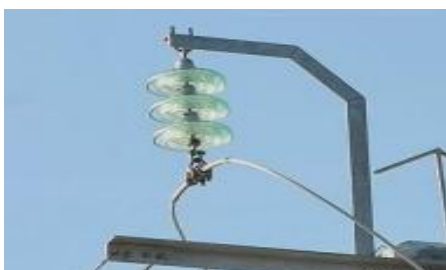
Figura 14. Armação em triângulo para alinhamento (TAL) [12]
