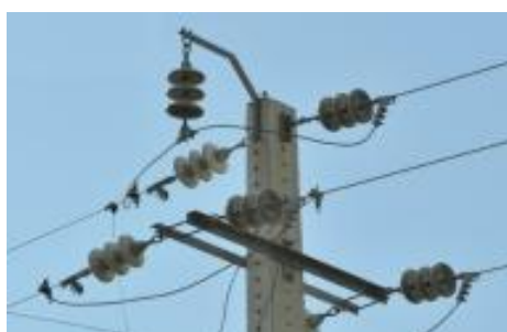
Figura 16. Armação em triângulo para ângulo (TAN) [12]
