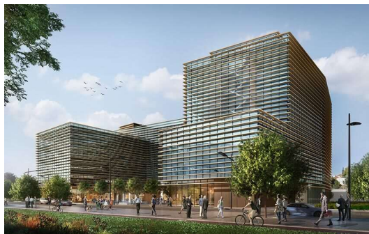
Figura 2.9 – Edifícios com elementos exteriores – EXEO Office Campus em Lisboa (em construção) [35].
