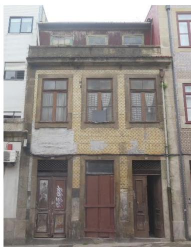
10 - Edifício Rua do Bonfim 109
