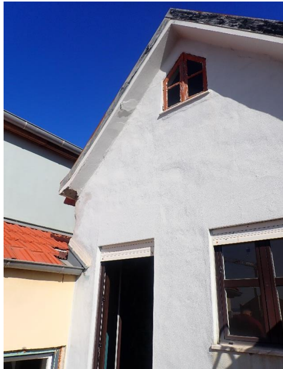
b) Casa Leça da Palmeira, fachada tardoz
