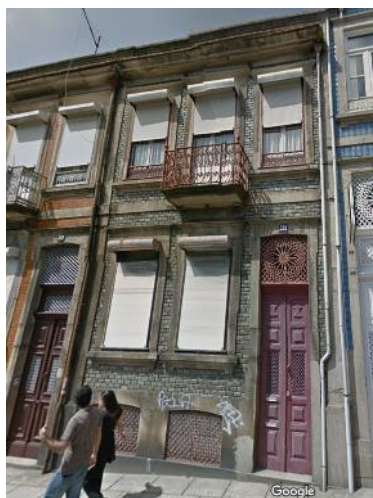
01 - Edifício Rua Álvares Cabral
