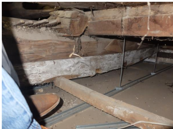
b) Vista por baixo da mansarda existente, espaço 2
