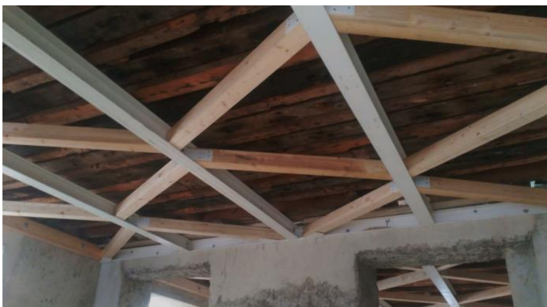
Figura 3.8 – Exemplo de uma medida para rigidificar diafragmas (Costa, 2015)
