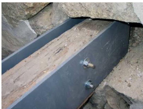
Figura 3.7 - Reforço na entrega de uma viga com recurso a chapa metálica(Costa, 2015)
