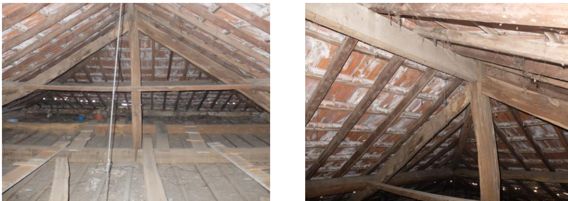
Figura 5.2 - Fotos gerais da parte da cobertura alvo de intervenção
