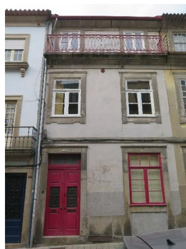
03 - Edifício Rua da Torrinha
