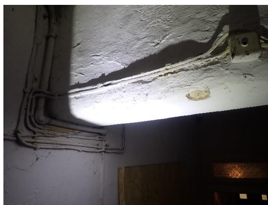
b) Padieira/ viga de cantaria de granito (piso 0)
