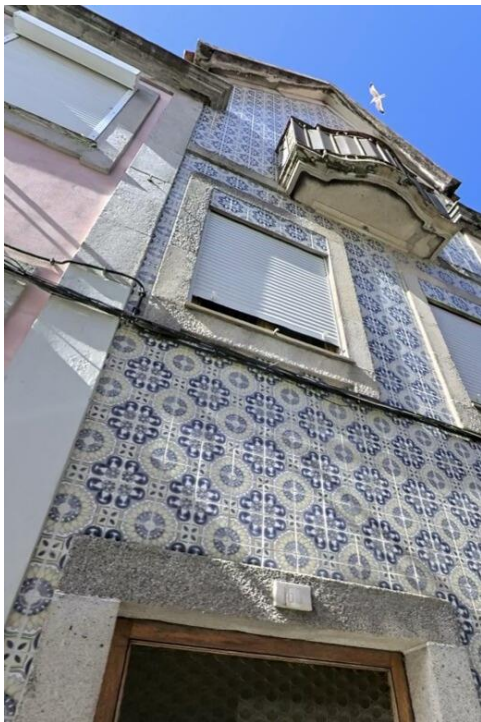
a) Casa Leça da Palmeira, fachada principal
