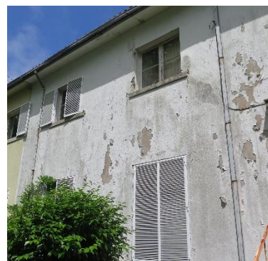
06 - Edifício Rua Soares de Passos
