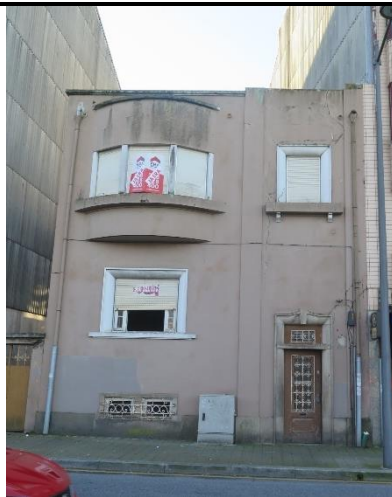
05 - Edifício Rua do Bolama
