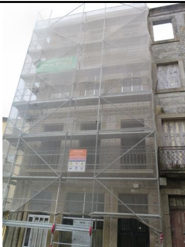
04 - Edifício Rua General Torres
