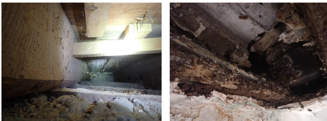
a) vigas de madeira do pavimento do piso 1
