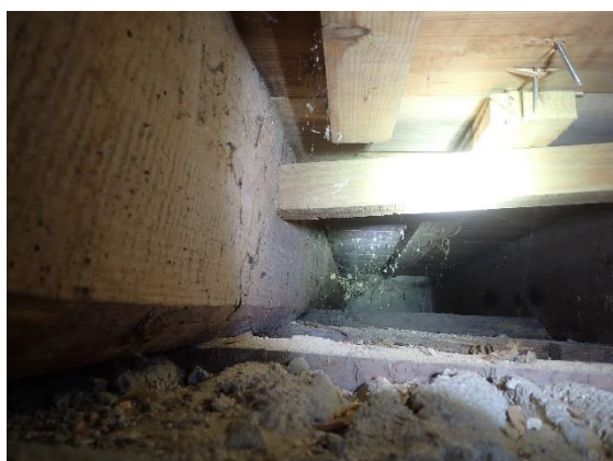
a) Pavimento de madeira (Piso 2)
