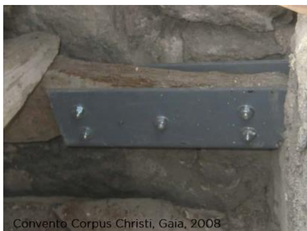
Figura 3.7 - Reforço na entrega de uma viga com recurso a chapa metálica(Costa, 2015)
