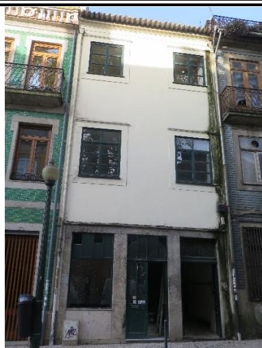
07 - Edifício Rua do Rosário
