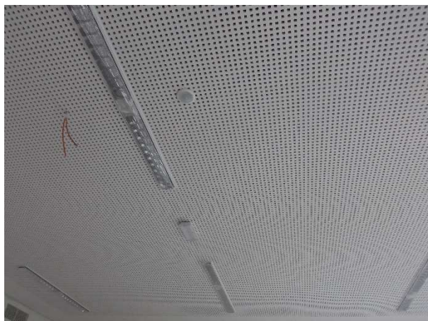
Figura 3.45 – Teto falso perfurado.
