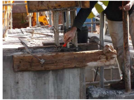
b) Aplicação de SikaTop Armatec – 110 EpoCem.
