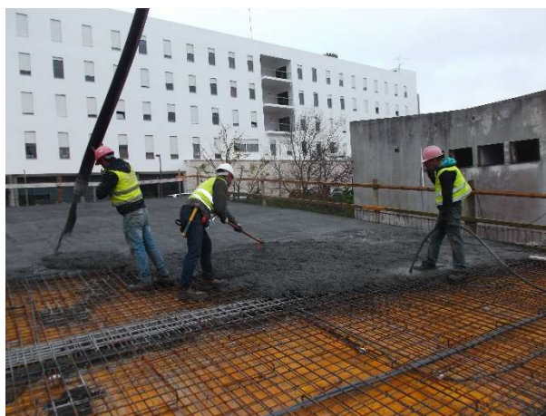
c) Betonagem da laje.
