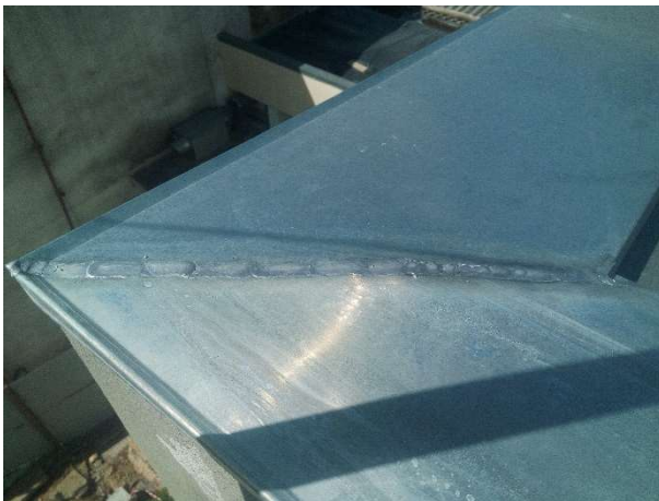
a) Soldadura de chapas de zinco.
