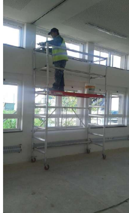
b) Andaime de apoio aos trabalhos de pintura.
