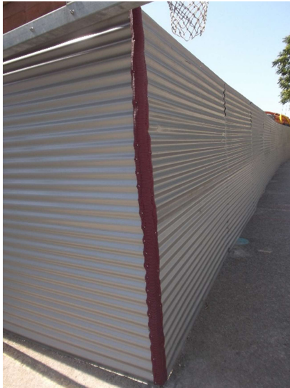
a) Proteção de cantos da vedação em chapa metálica.
