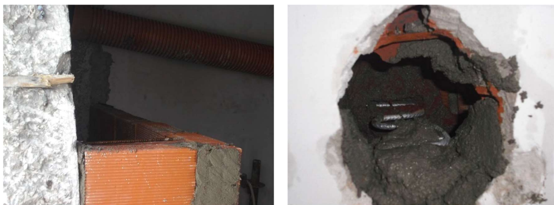
a) – Gateamento de panos à estrutura.
