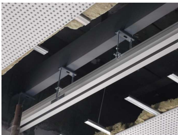
a) Fixações da calha metálica à viga.
