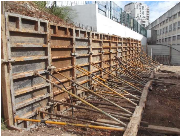
a) Cofragem inicial.
