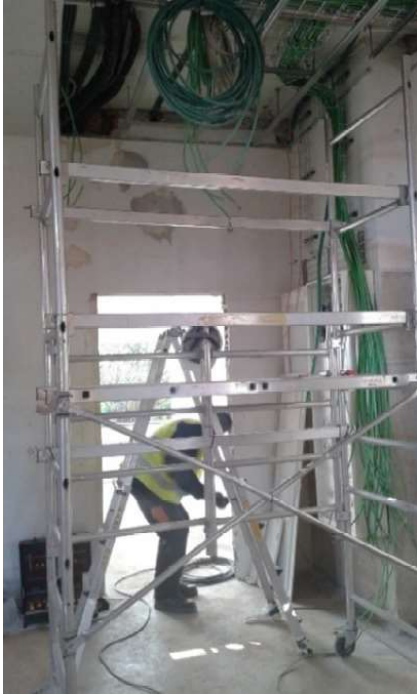
a) Andaime de apoio aos trabalhos de eletricista.
