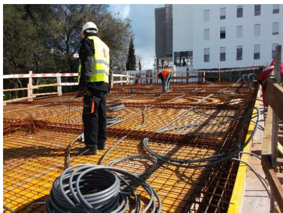
a) Armação da laje.
