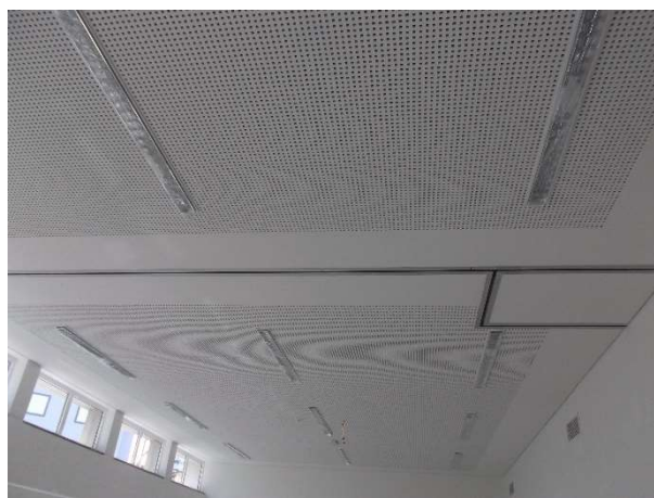
b) Calha metálica concluída.
