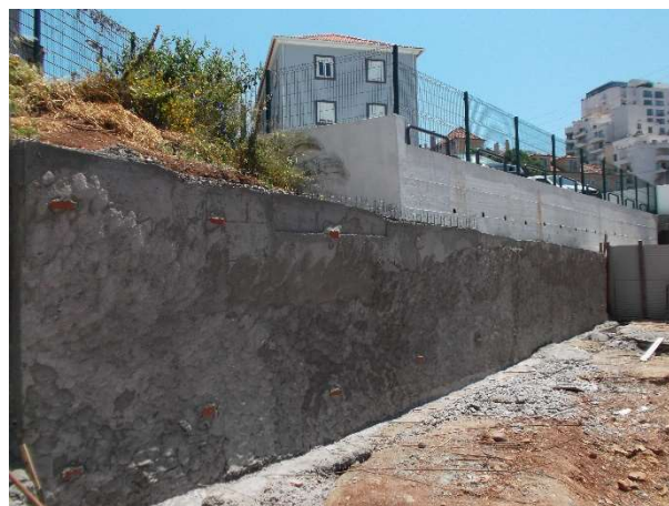
Figura 3.36 – Muro betonado e salpicado.
