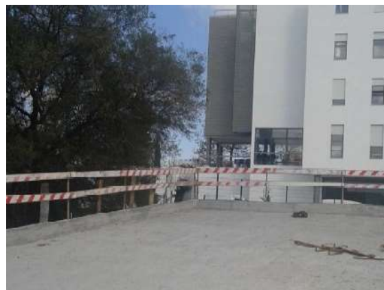
b) Guarda corpos da cobertura do pavilhão gimnodesportivo.
