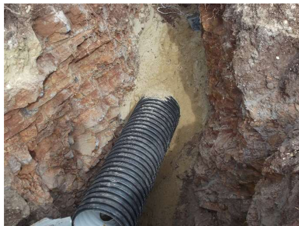
Figura 3.39 – Aterro de vala para assentamento de tubagem.
