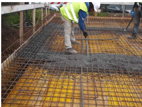
b) Betonagem das vigas.
