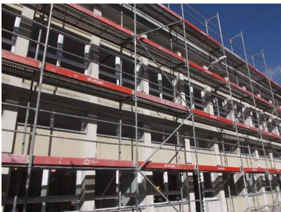
a) Andaime exterior montado na fachada nascente.
