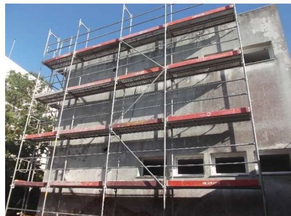
b) Andaime exterior montado na fachada Norte.
