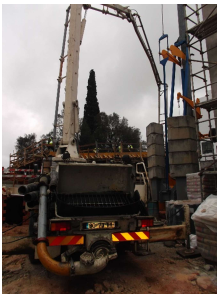
a) Autobomba alugada para a betonagem.
