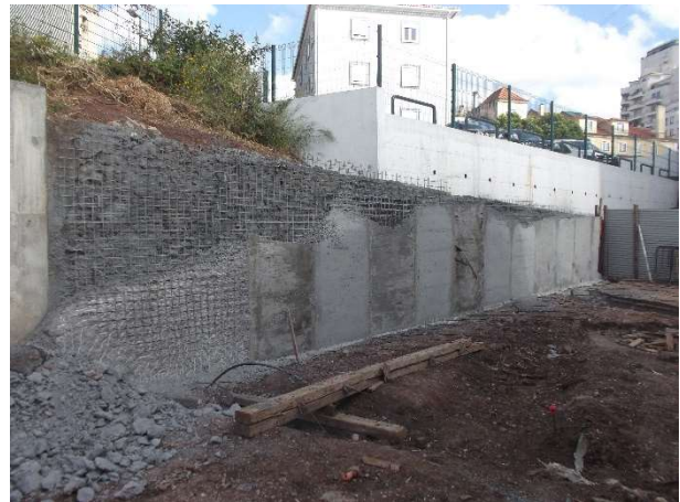
b) Picagem do muro.
