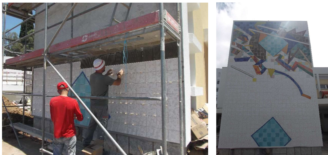
a) Assentamento do cerâmico.
