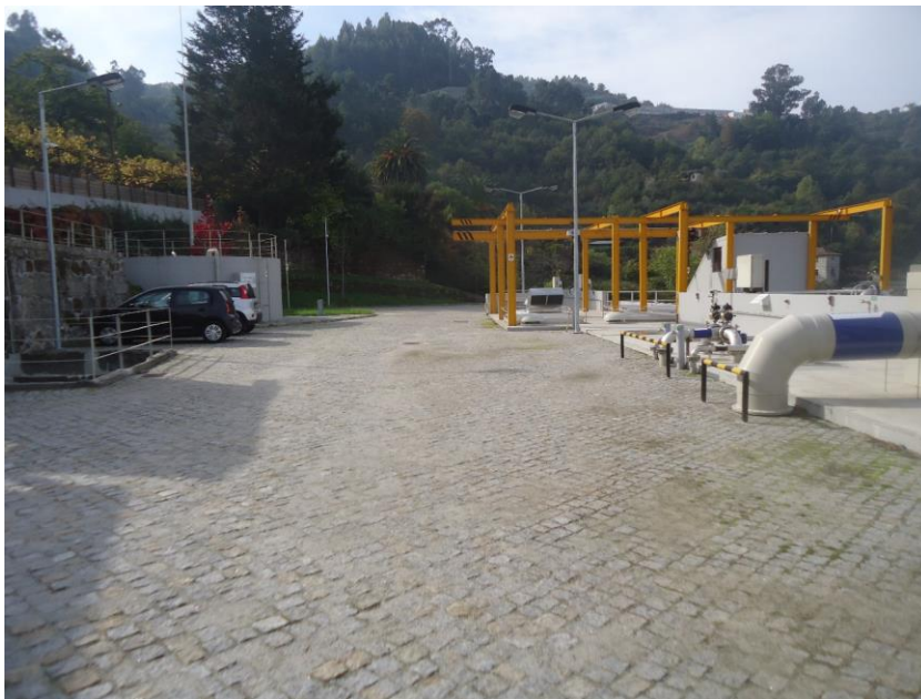
FIGURA 11: VIA INTERNA DE EVACUAÇÃO NA ETAR DE FORNOS (FONTE: RECOLHA PRÓPRIA)
