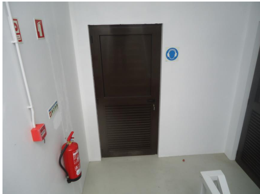
FIGURA 9: VIA DE EVACUAÇÃO NA ETAR DE FORNOS (FONTE: RECOLHA PRÓPRIA)
