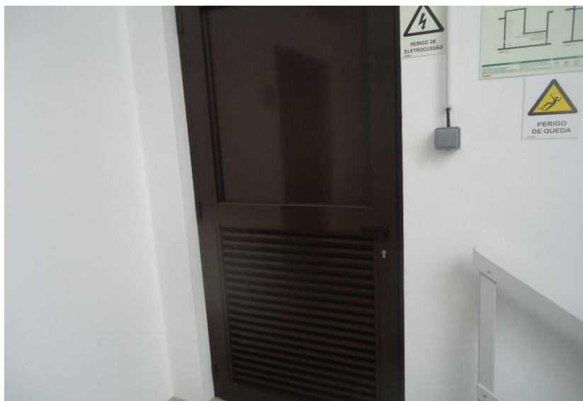
FIGURA 8: VIA DE EVACUAÇÃO NA ETAR DE FORNOS (FONTE: RECOLHA PRÓPRIA)
