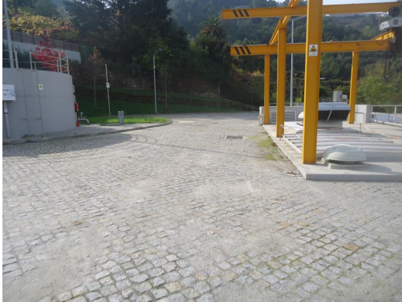
FIGURA 10: VIA INTERNA DE EVACUAÇÃO NA ETAR DE FORNOS (FONTE: RECOLHA PRÓPRIA)
