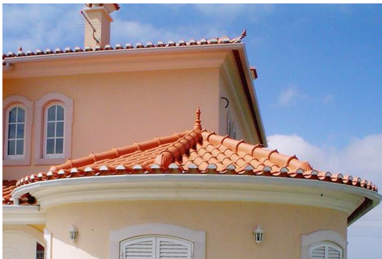
Figura 6 - Caleira de beiral de secção quadrangular
