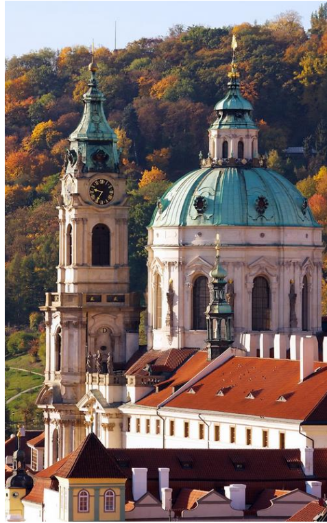
Figura 3 - Igreja S. Nicolau, Praga - República Checa – Cobertura em cobre
