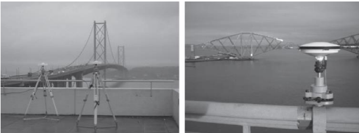
Figura 2.10 – Antenas GNSS instaladas em pontes suspensas.
