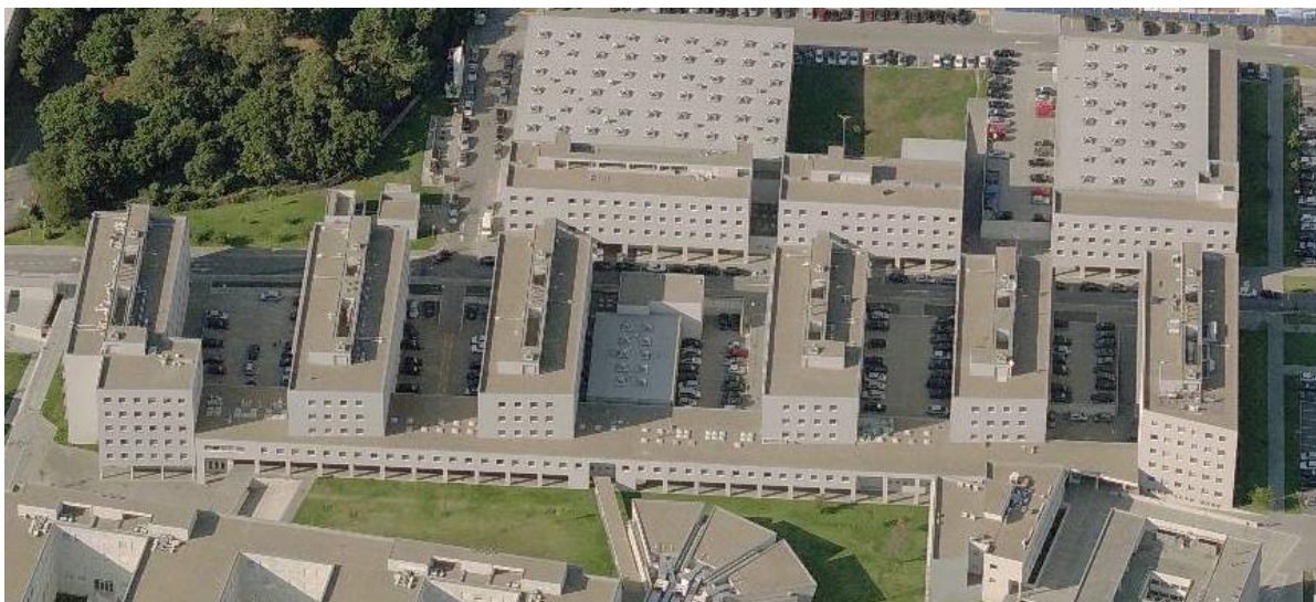
Figura 4.13 – Envolvente dos Edifícios da Faculdade de Engenharia da Universidade do Porto.
