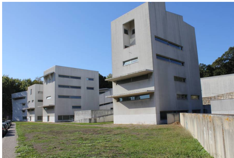
Figura 4.1 – Edifícios da Faculdade de Arquitectura do Porto.
