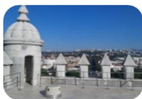
Cobertura acessível a pessoas - terraço
