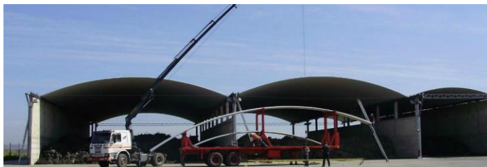
Figura 3.5 – Cobertura de edifício industrial.
