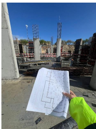
Figura 41 - Verificação da execução dos quebra-cantos em pilares
