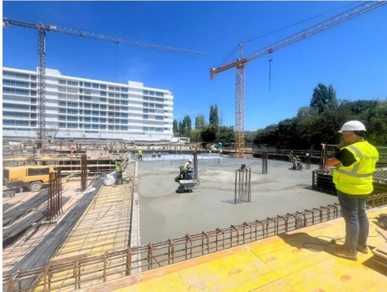
Figura 43 - Betonagem da laje superior do piso -2
