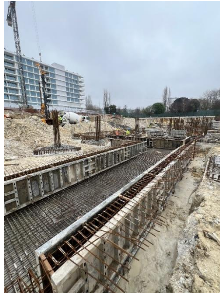
Figura 37 - Cofragem da galeria técnica
