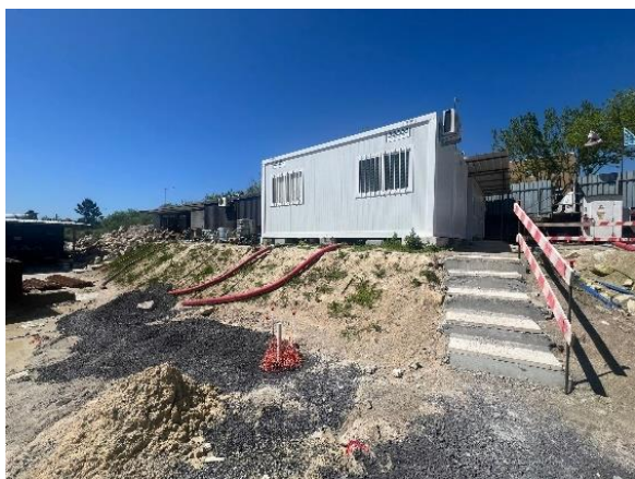
Figura 15 - Estaleiro afeto à Equipa de Direção de Obra
