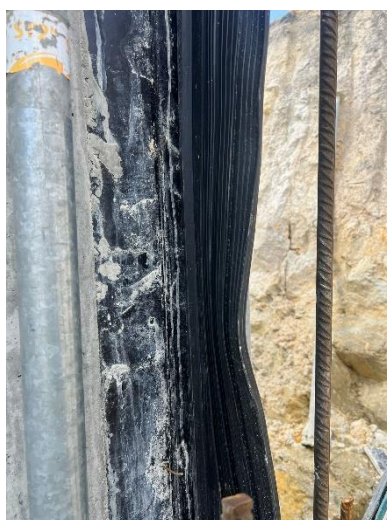
Figura 40 - Junta de dilatação
