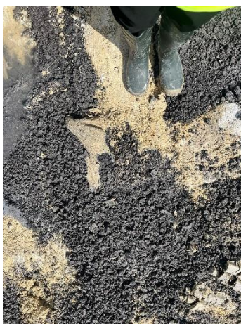
Figura 20 - Mistura de inertes aplicada no solo
