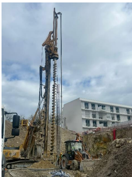
Figura 22 - Execução de estacas em trado contínuo
