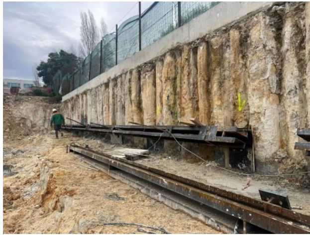
Figura 29 - Viga provisória pré-fabricada
