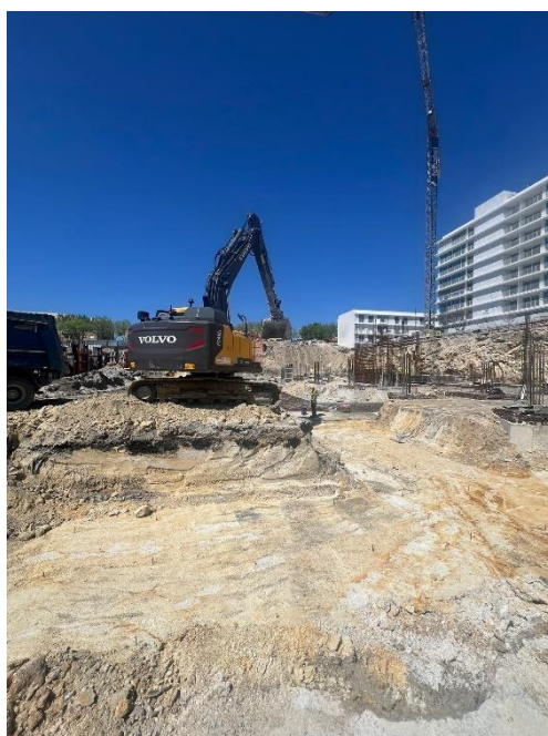
Figura 18 – Escavação para abertura de plataforma de projeto
