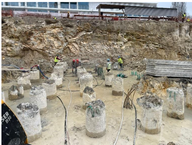
Figura 23 - Método 1 de saneamento de estacas
