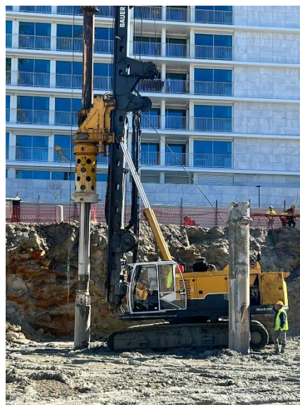
Figura 21 - Execução de estacas com Vara Kelly
