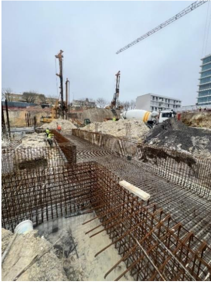
Figura 36 - Armadura da galeria técnica
