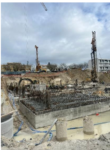
Figura 34 - Sapata do núcleo de escadas betonada
