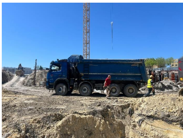
Figura 19 - Carga das terras provenientes da escavação
