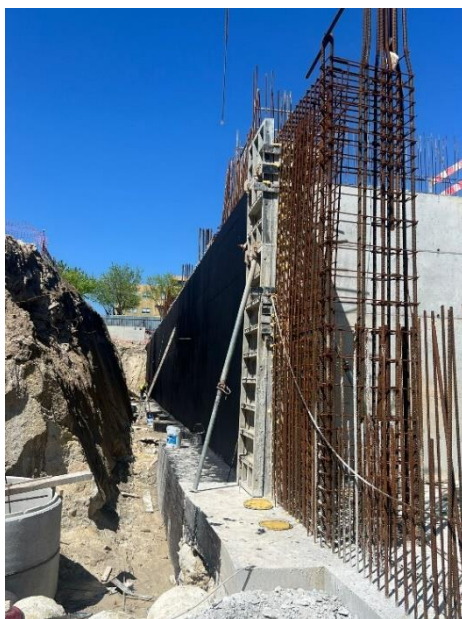
Figura 39 - Muro de contenção lateral do bloco B4
