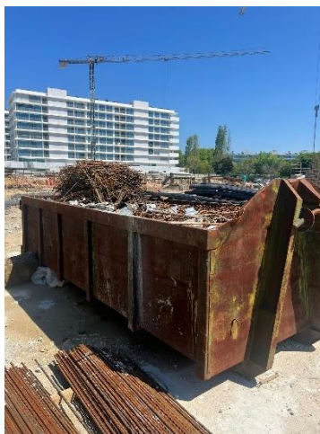
Figura 16 - Depósito de sobras de aço
