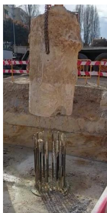
Figura 24 - Método 2 para saneamento de estacas
