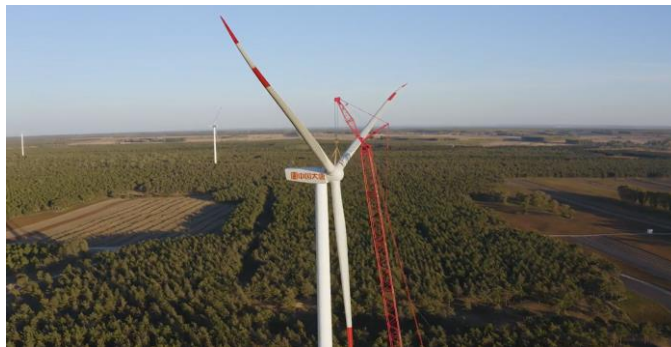
Figura 13 - Instalação das pás da turbina eólica no parque eólico em Tieling, China [39].
