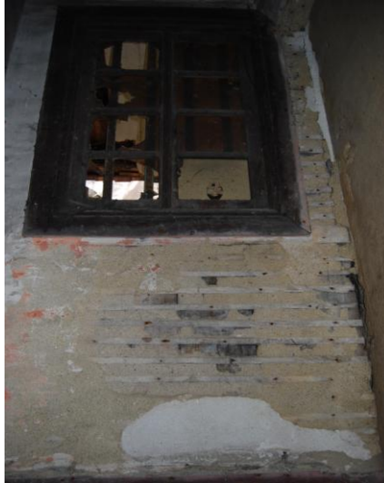
Figura 4.10 – Janela vista pelo interior da habitação (Porto Vivo, SRU)
