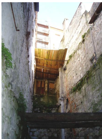
Figura 4.98 – Interior do edifício do Projeto 4 (Porto Vivo, SRU)
