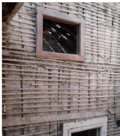
Figura 4.56 – Parede divisória em tabique (Porto Vivo, SRU)
