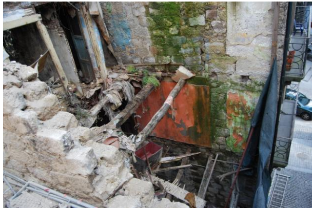
Figura 4.2 – Parede meeira em alvenaria de pedra (Porto Vivo, SRU)
