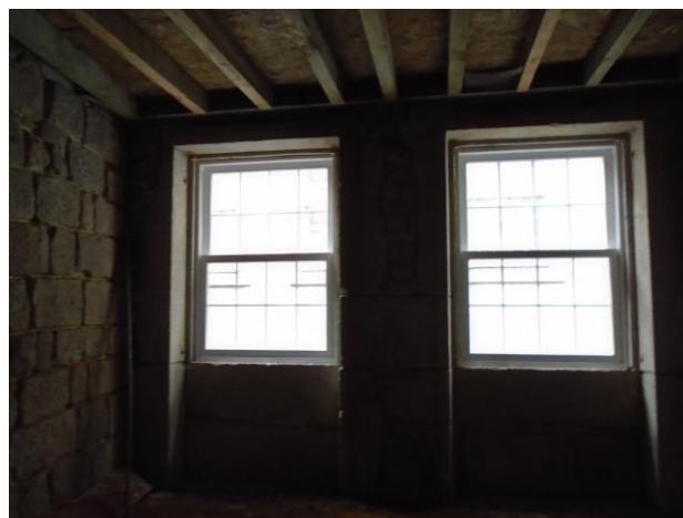
Figura 5.7 – Placa OSB e caixilharia de madeira
