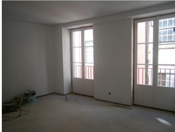
Figura 5.3 – Pintura no interior numa das habitações da Operação A
