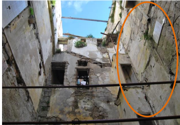
Figura 4.54 – Parede meeira em alvenaria de pedra (Porto Vivo, SRU)
