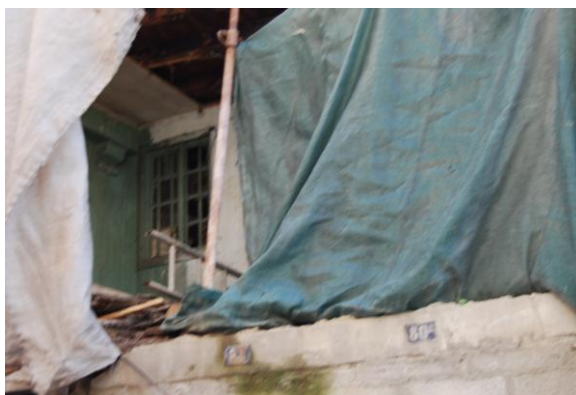
Figura 4.9 – Janela da Operação A (Porto Vivo, SRU)
