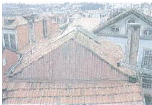
Figura 4.58 – Vista da cobertura do Projeto 3 (Porto Vivo, SRU)
