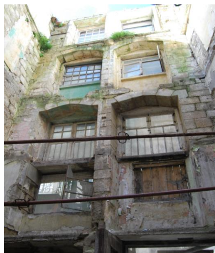
b) Fachada frontal vista pelo interior (Porto Vivo, SRU)
