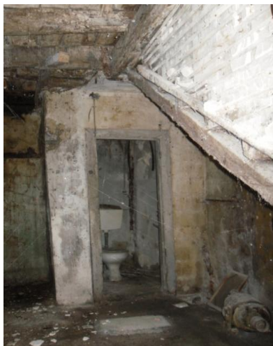
Figura 4.55 – Parede divisória em alvenaria de tijolo (Porto Vivo, SRU)
