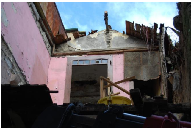
Figura 4.8 – Cobertura inicial na Operação A (Porto Vivo, SRU)
