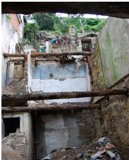
Figura 4.4 – Parede divisória em alvenaria de tijolo revestida com azulejo (Porto Vivo, SRU)
