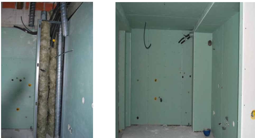
Figura 5.1 – Colocação das paredes de gesso cartonado
