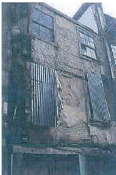
Figura 4.1 – Fachada principal em tabique (Porto Vivo, SRU)
