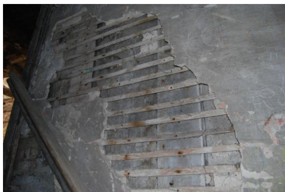
Figura 4.5 – Parede divisória em tabique (Porto Vivo, SRU)
