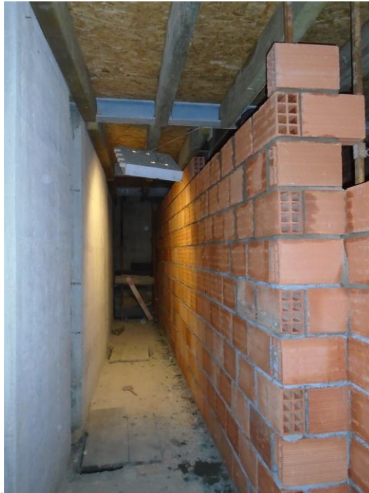
Figura 5.6 – Realização de parede de alvenaria de tijolo do r/c
