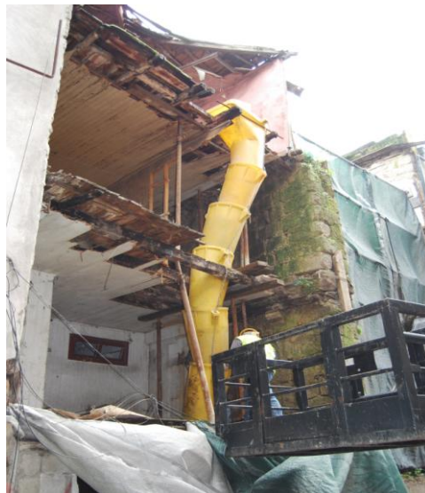
Figura 4.3 – Alvenaria de tijolo revestida com madeira (Porto Vivo, SRU)
