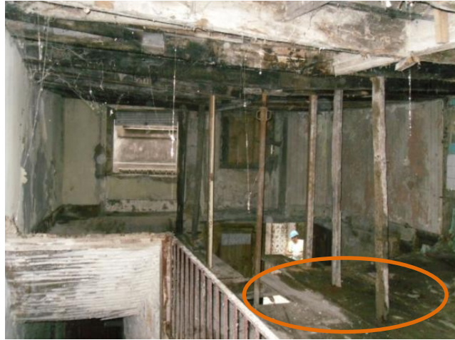
Figura 4.57 – Pavimento intermédio em madeira (Porto Vivo, SRU)
