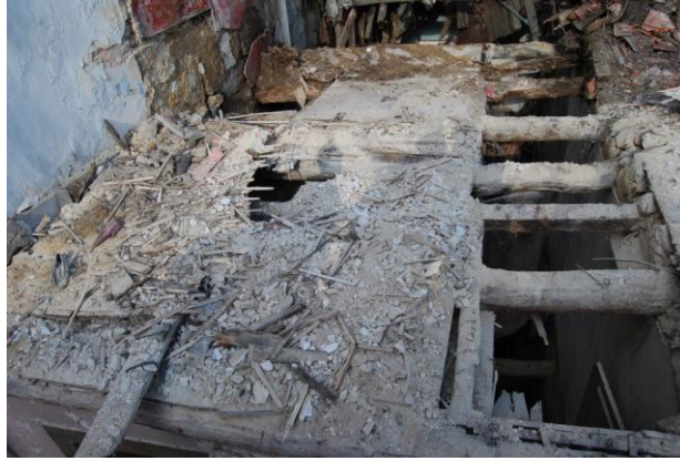
Figura 4.6 – Pavimento intermédio em madeira (Porto Vivo, SRU)
