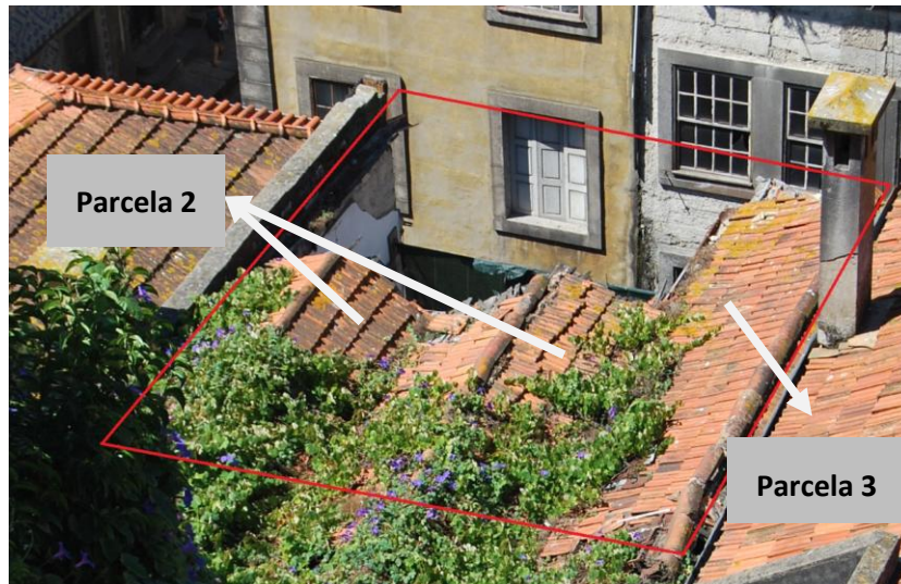
Figura 4.7 – Vista aérea da cobertura inicial da Operação A (Porto Vivo, SRU)
