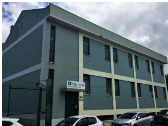
Figura 2- Sede da IBERDATA, Amadora- Portugal.
