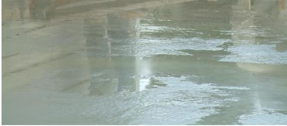
Figura 3. 4 Exemplo do fenômeno de sangramento num pavimento, adaptado de [15].
