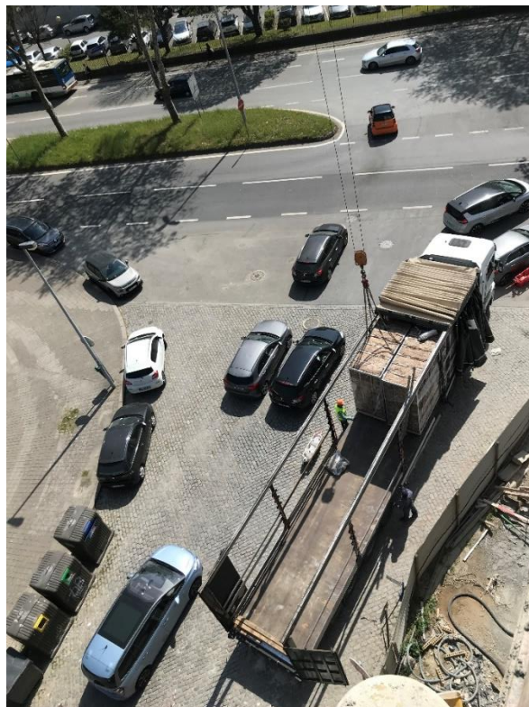
Figura 4-3 Camião estacionado no local próprio já com a caçamba aberta, (autor do trabalho)
