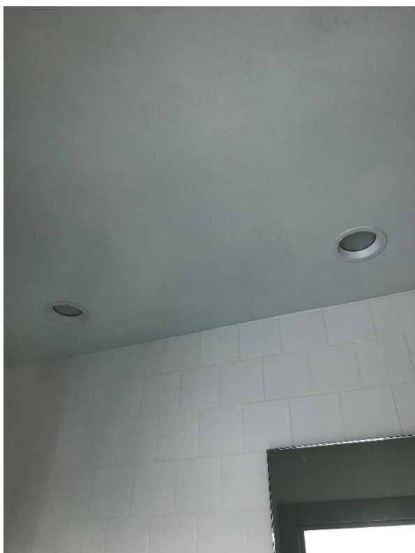
a) Luminárias em perfeitas condições
