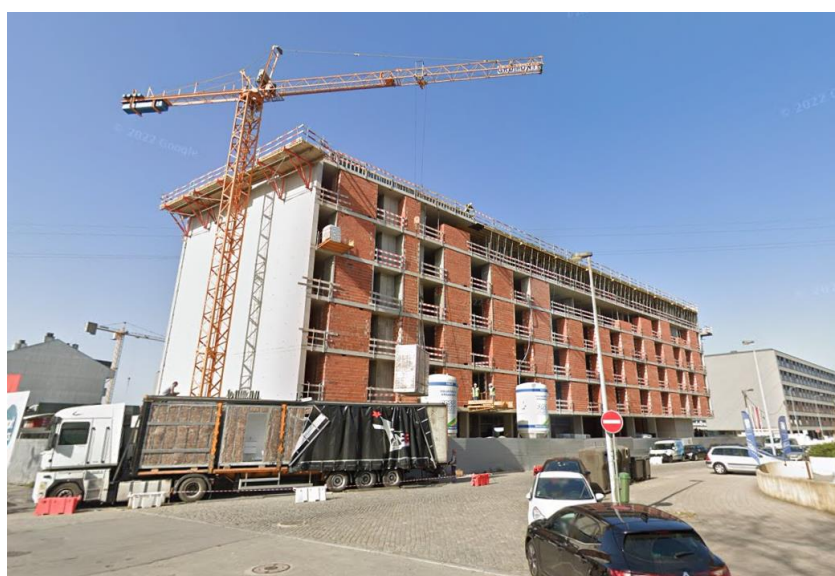
Figura 2-4 Terreno de implantação (durante a execução da obra), (maps, 2022)
