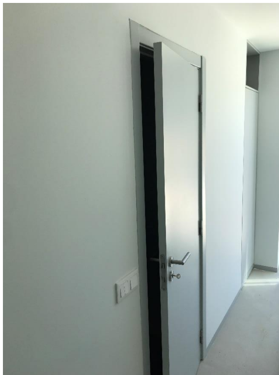
Figura 4-17 Aspeto final exterior do monobloco (autor do trabalho)
