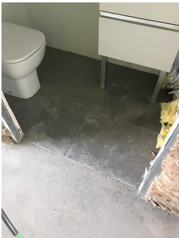
a) Tijoleira colocada corretamente
