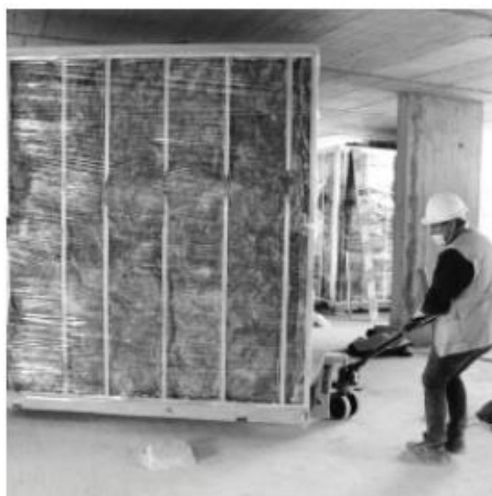
Figura 4-6 Transporte dos monoblocos no interior do edifício com recurso a porta-paletes, (Transmodulo, 2022)
