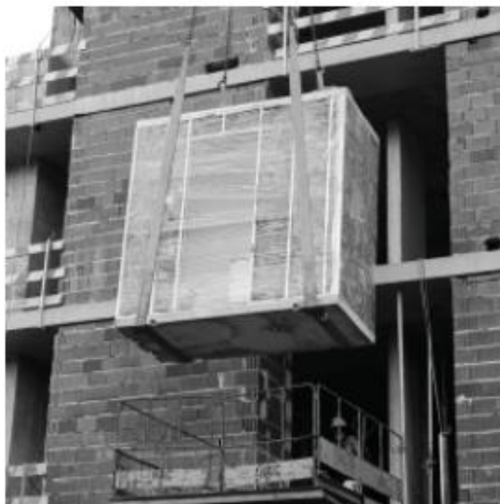
Figura 4-5 Elevação dos monoblocos até ao piso pretendido, (Transmodulo, 2022)
