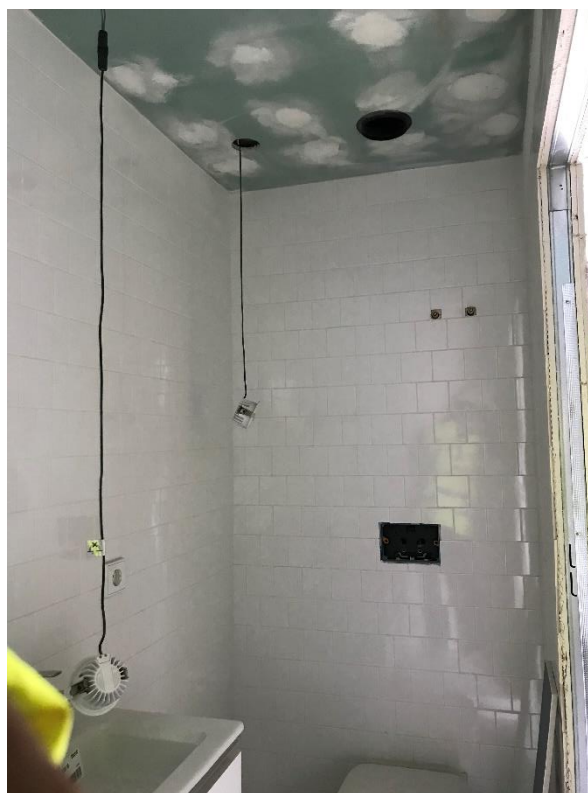
b) Luminárias por fixar
