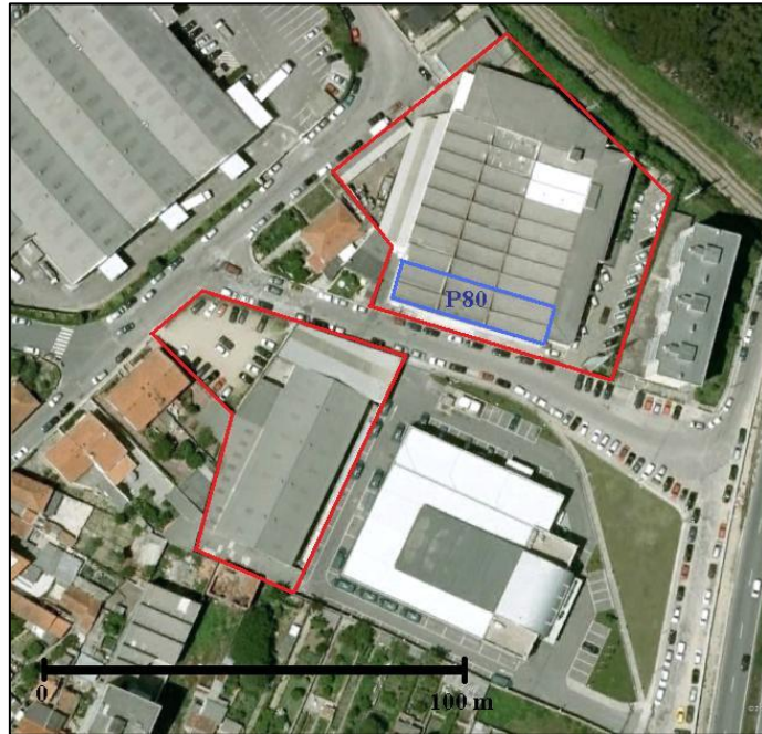
Figura 2 – Instalações a Sul
