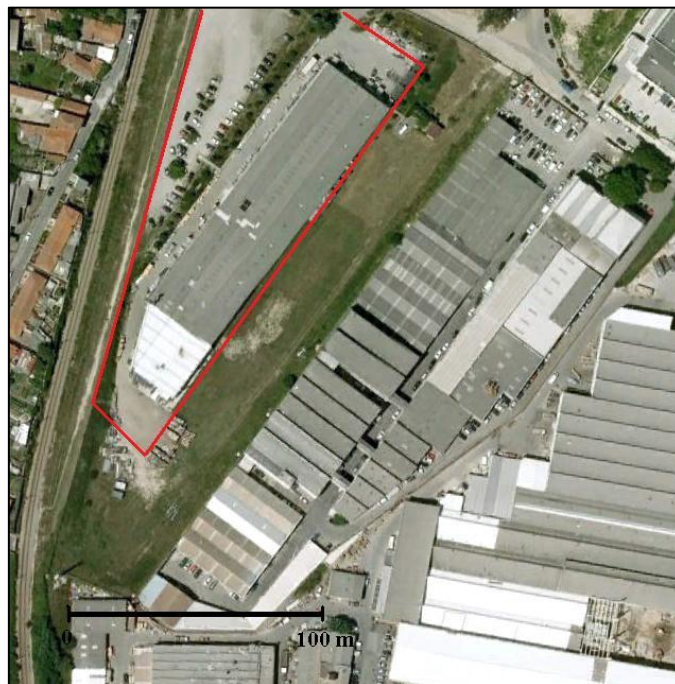
Figura 3 - Instalações a Norte
