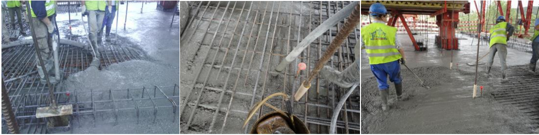
Figura 29 - Betonagem, vibração e pulverização de membrana de cura
