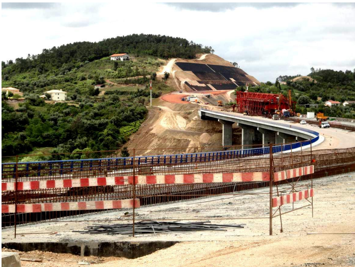
Figura 26 - Ponte onde ocorreram betonagens após realização da composição de betão
