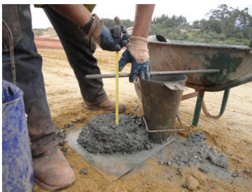
Figura 28 - Ensaio slump realizado em obra – controlo de qualidade
