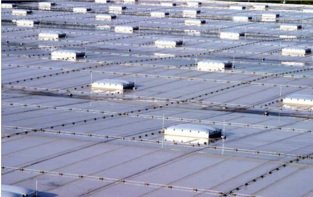
Figura 12 - Exemplo de um Sistema Gaiola de Faraday [18]
