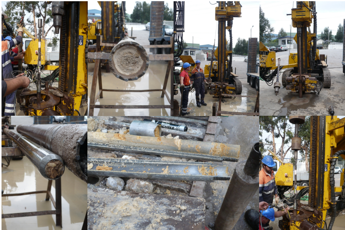
Figura 29 - Equipamento utilizado na 1ª e 2ª campanha (Estaleiro de Canelas)
