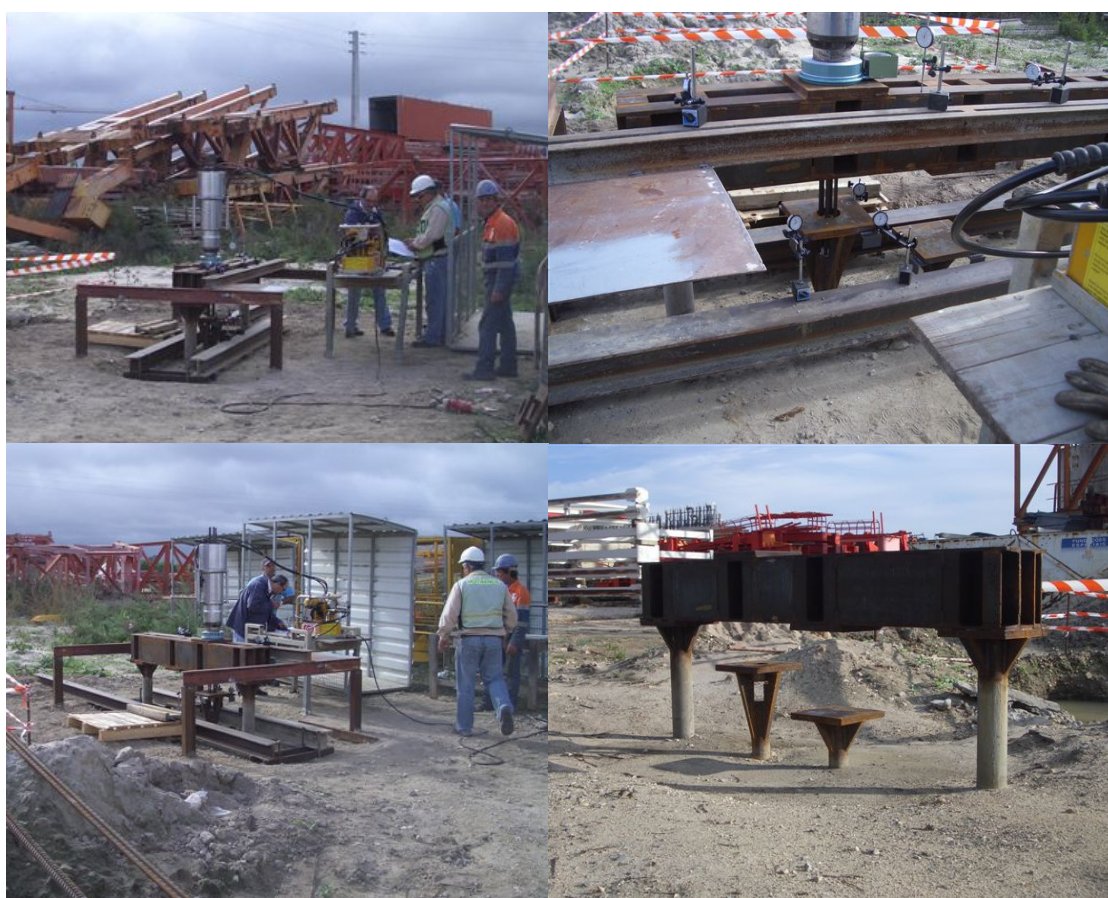
Figura 66 – Ensaio de carga sobre a micro-estaca no Estaleiro de Porto Alto
