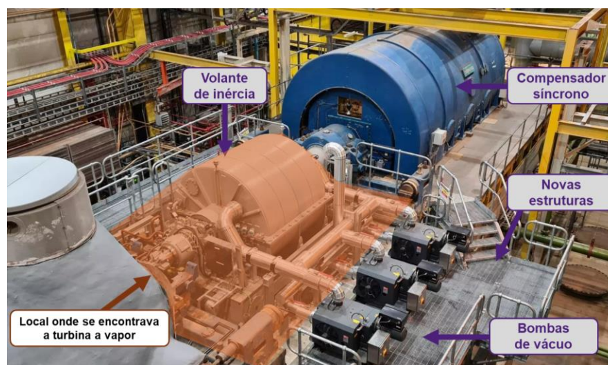
Figura 25 – Exemplo de conversão com adição de volante de inércia. Adaptado de [109].
