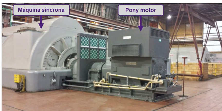
Figura 28 – Exemplo de um compensador síncrono equipado com pony motor . Adaptado de [118].
