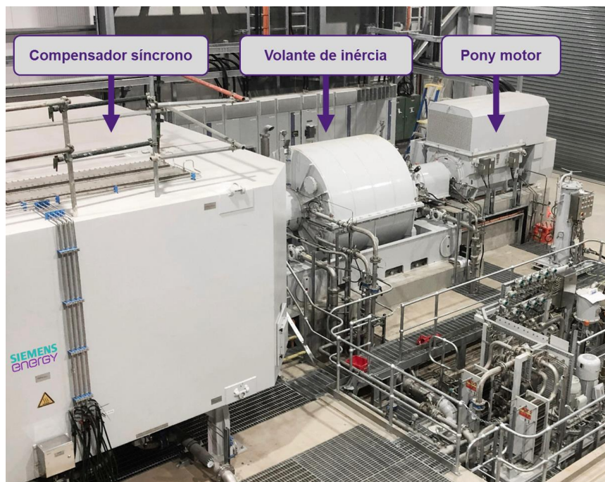
Figura 19 – Exemplo de compensador síncrono equipado com volante de inércia e pony motor . Adaptado de [92].
