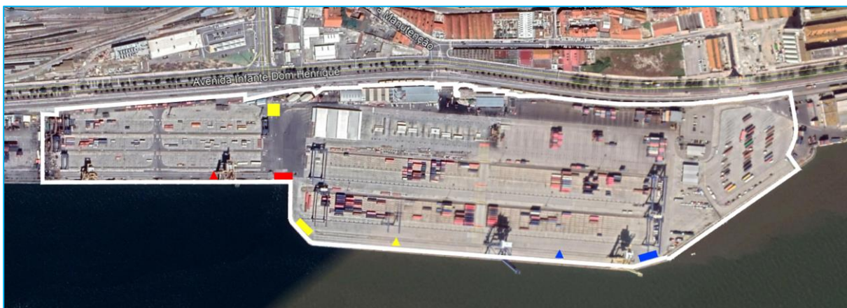
Figura 3.39-Implantação de equipamentos no Terminal de Contentores de Santa Apolónia (SOTAGUS)
