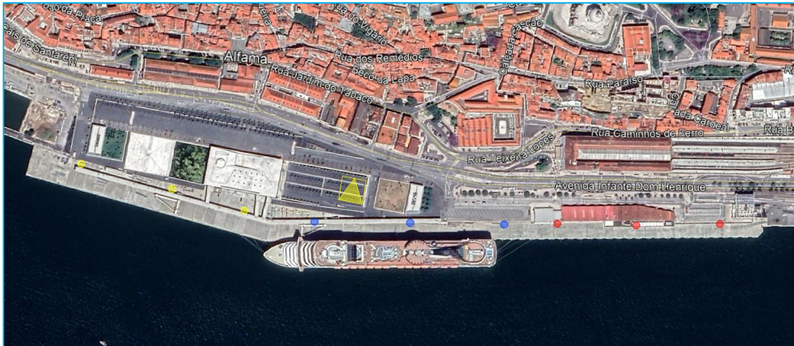
Figura 3.34-Implantação de equipamentos no Terminal de Cruzeiros de Lisboa (LCP)
