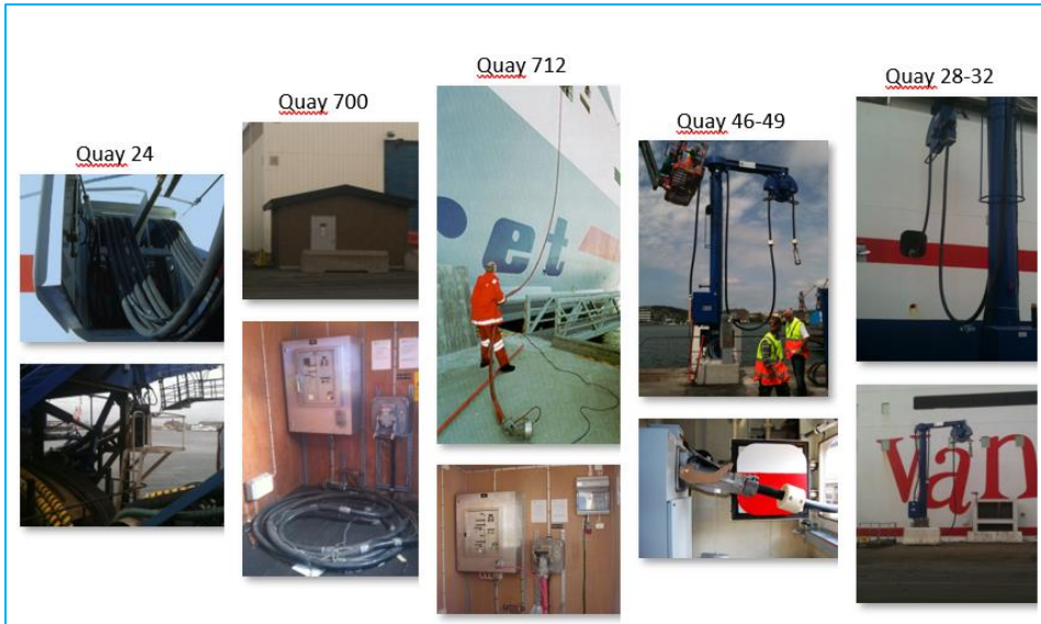
Figura 2.14-Imagens dos vários terminais e instalações shore-to-ship em finais de 2013. [37] [6]
