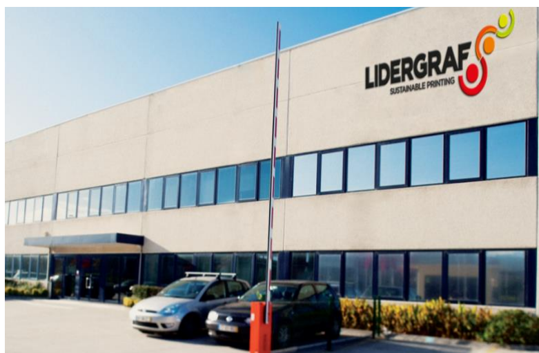
Figura 1 – Edifício Lidergraf em Vila do Conde
