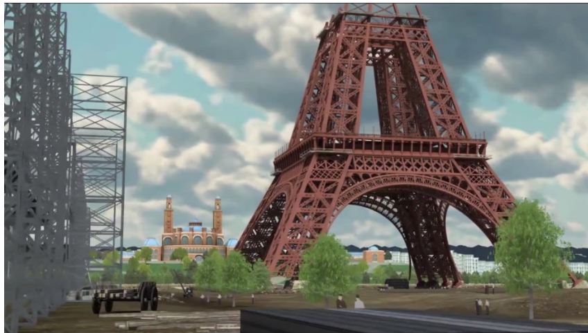
Figura 51 - Processo de construção da torre Eiffel
