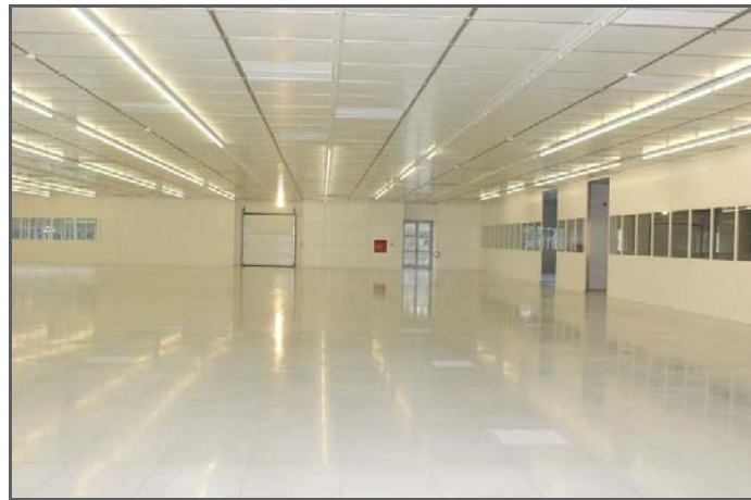
Figura 4 Imagem de sala limpa antes da instalação de equipamentos
