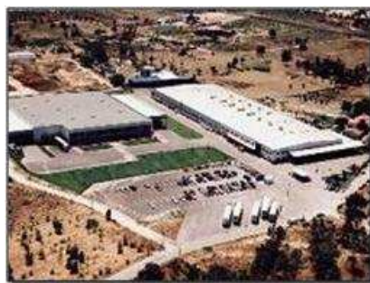
Figura 10 Instalações da Continental Teves Portugal, Lda.
