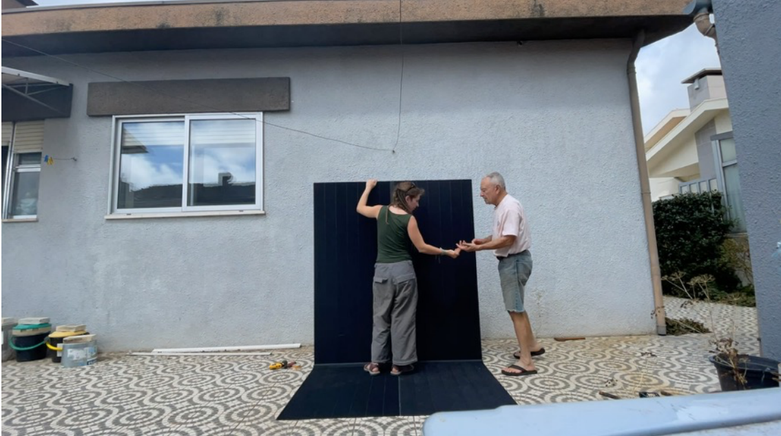
Figura 19 Finalização da estrutura (créd. Frederica Campos)
