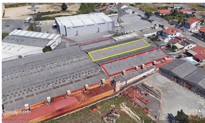
Figura 51 Área da instalação dos módulos FV
