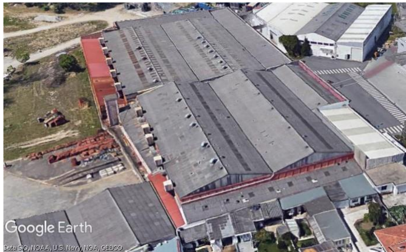
Figura 50 Vista lateral dos edifícios da empresa E
