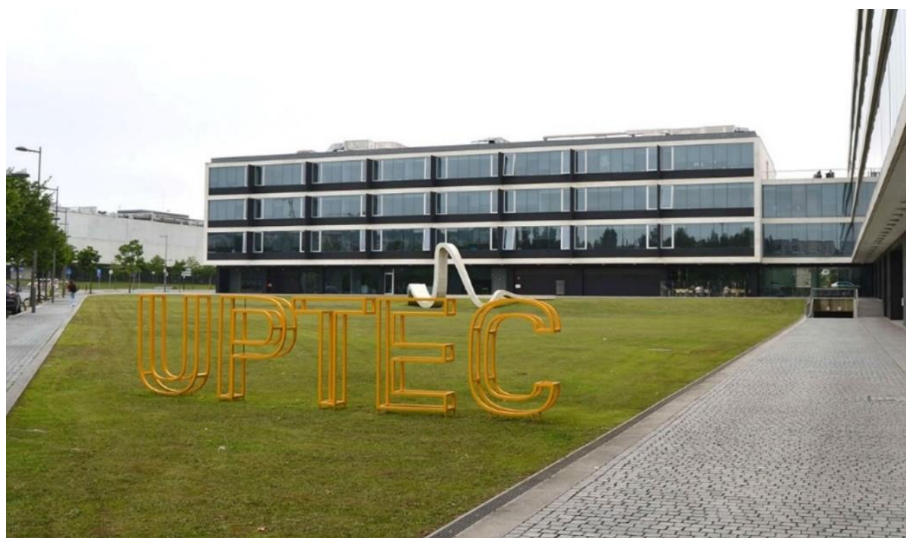
Figura 1. Edifício UPTEC dentro do qual se situa a sede da inovapotek, Pharmaceutical Research & Development
