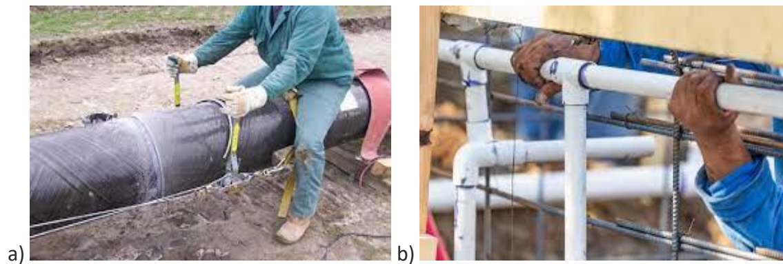
Figura 35 – Juntas adesivas tubulares aplicadas no (a) transporte de combustíveis [71] e na (b) engenharia civil [75]
